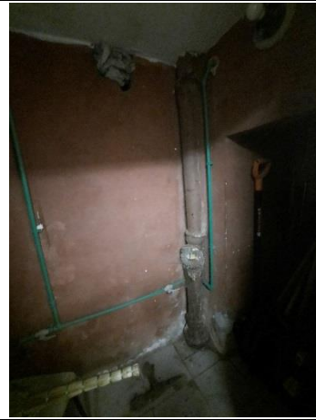
Фото № 12. Внутреннее состояние помещения
