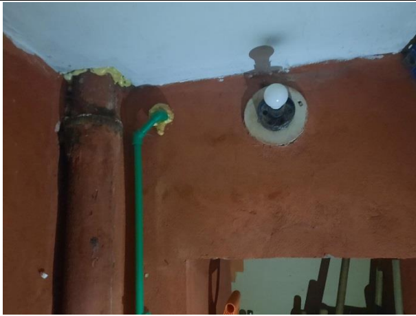
Фото № 13. Внутреннее состояние помещения
