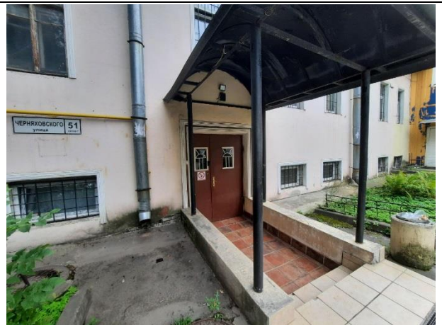
Фото № 8. Вход в здание
