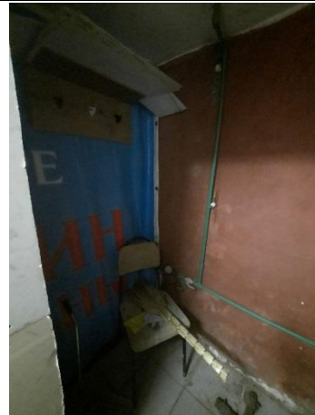
Фото № 10. Внутреннее состояние помещения
