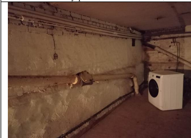
Фото № 9 – Внутреннее состояние помещения
