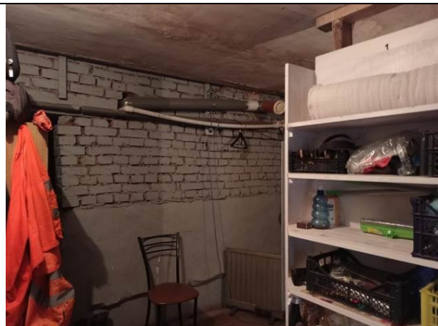
Фото № 16 – Внутреннее состояние помещения
