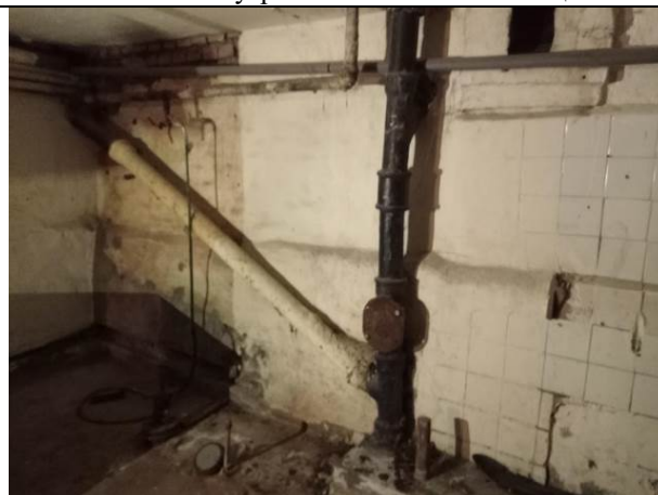
Фото № 10 – Внутреннее состояние помещения
