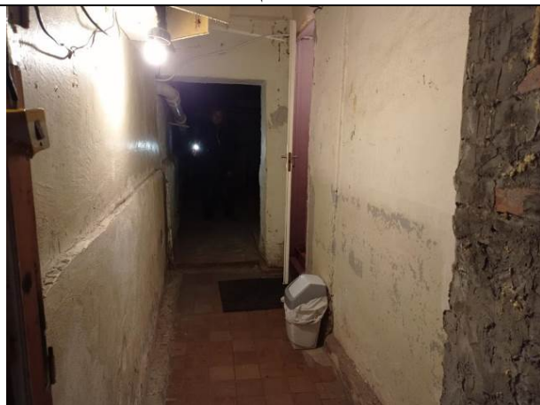
Фото № 6 – Внутреннее состояние помещения
