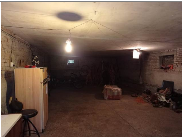
Фото № 5 – Внутреннее состояние помещения
