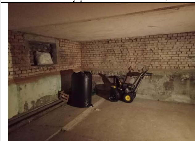
Фото № 11 – Внутреннее состояние помещения
