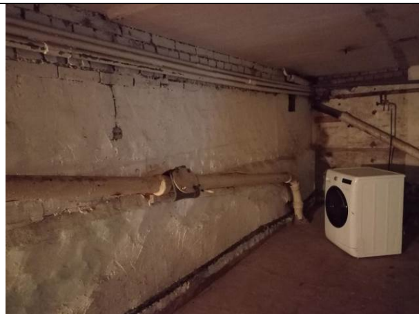
Фото № 8 – Внутреннее состояние помещения
