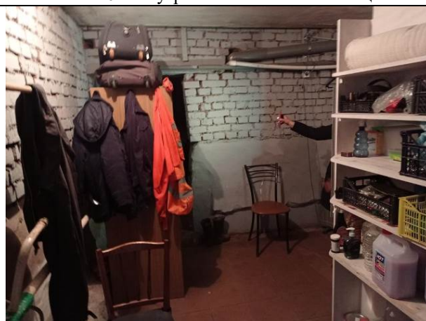
Фото № 12 – Внутреннее состояние помещения
