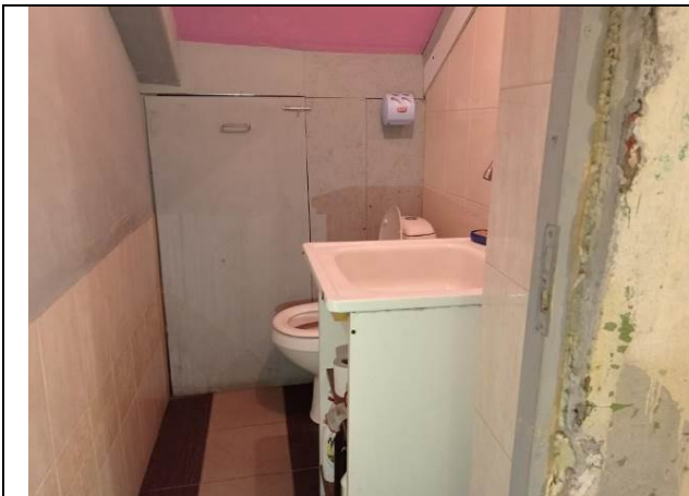
Фото № 7 – Внутреннее состояние помещения
