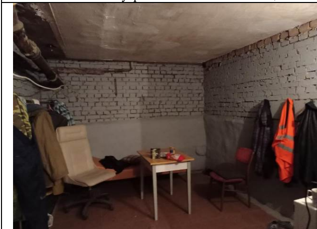
Фото № 13 – Внутреннее состояние помещения
