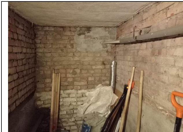
Фото № 15 – Внутреннее состояние помещения
