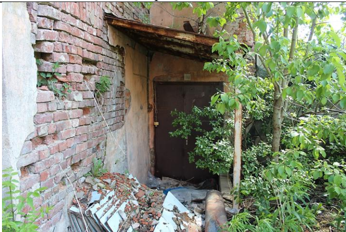
Фото № 5. Вид на вход со стороны Южного фасада
