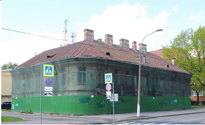
Фото № 1. Вид на Северный и Восточный фасады с улицы Велещинского
