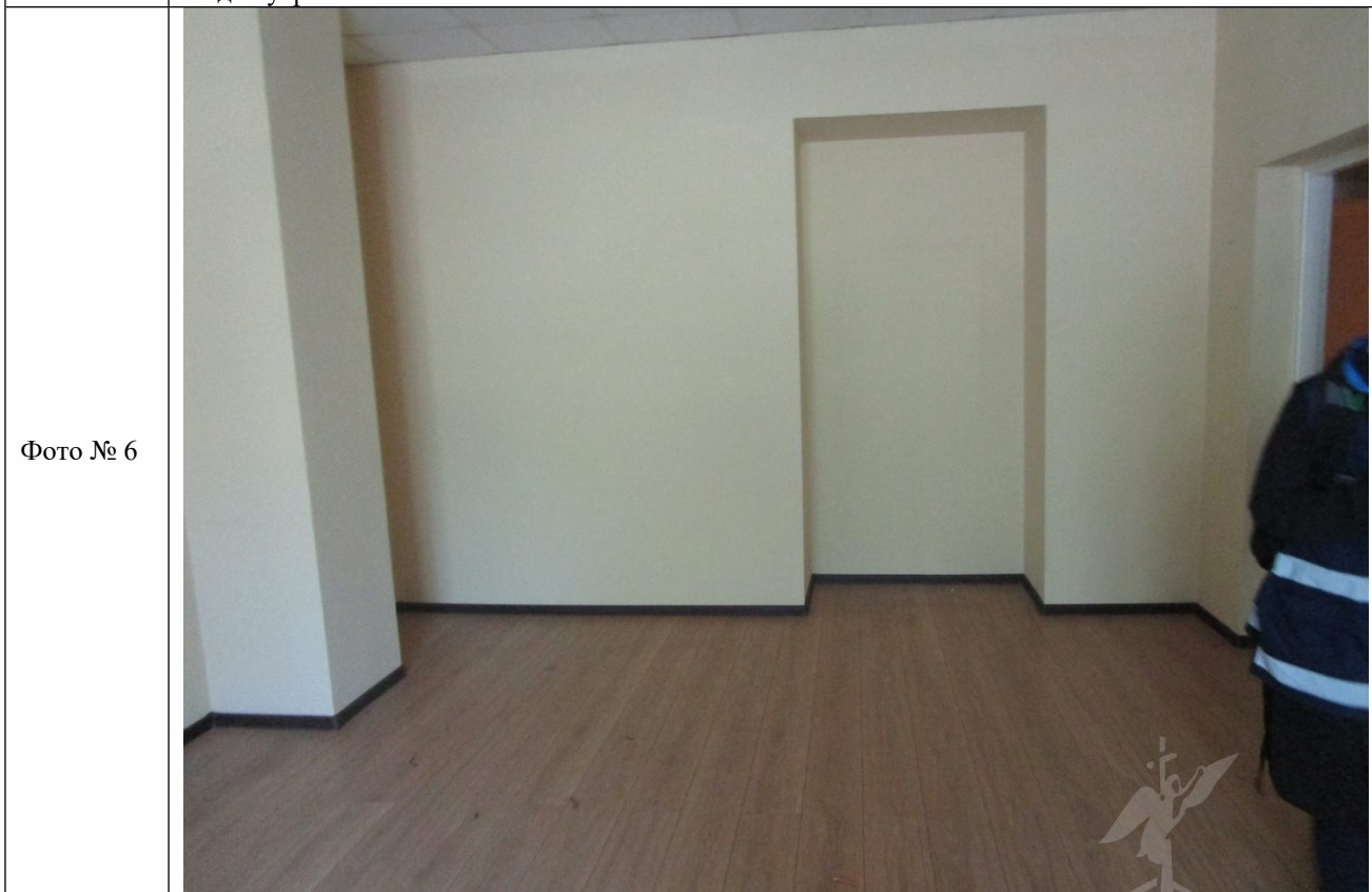
Описание: В ч.п. 5 Объекта оборудована ниша
