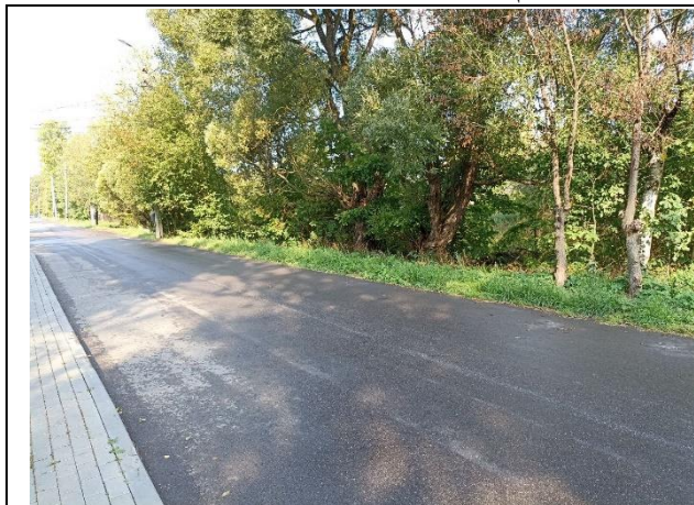
Фото № 1. Подъездные пути и окружение объекта
