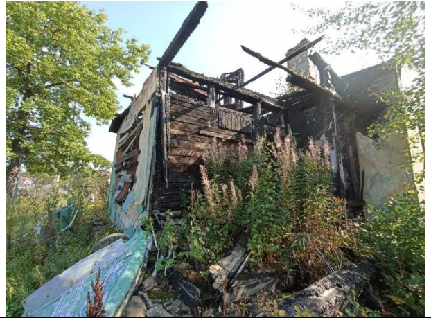
Фото № 8. Внешний вид здания
