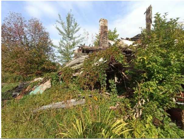
Фото № 7. Внешний вид земельного участка и здания
