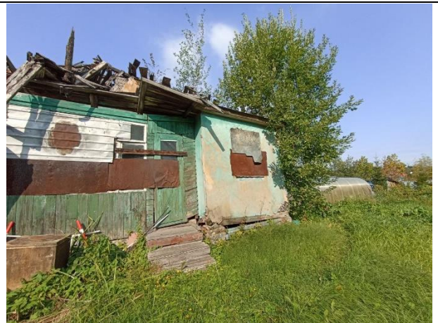
Фото № 12. Внешний вид здания
