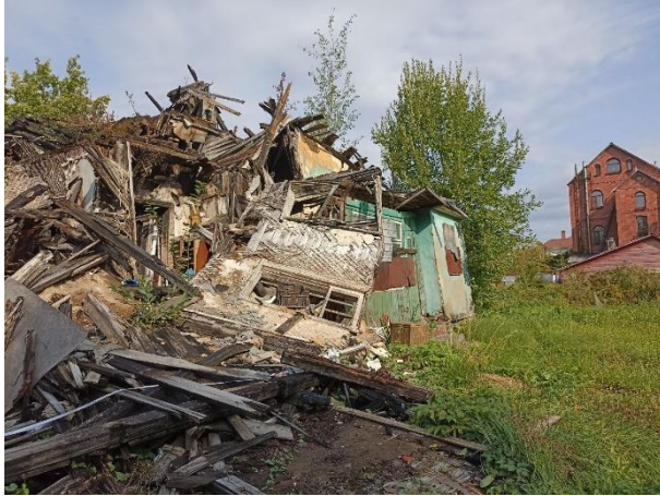
Фото № 9. Внешний вид здания
