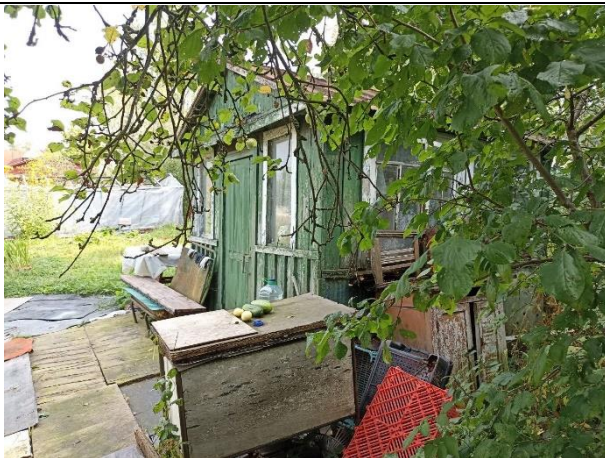
Фото № 11. Внешний вид здания
