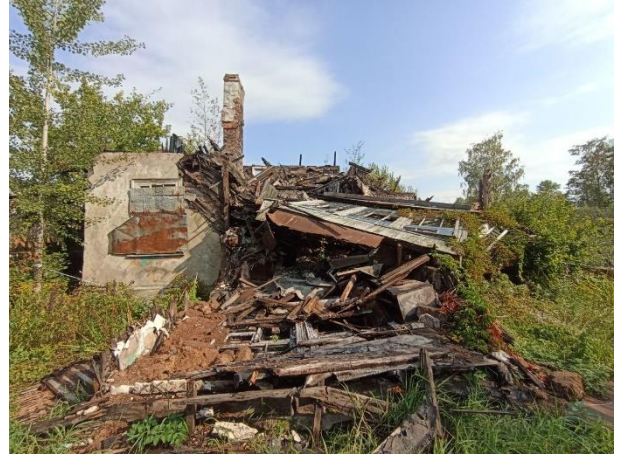
Фото № 10. Внешний вид здания
