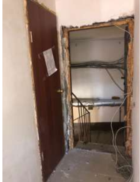
Фото 16. Внутреннее состояние Объекта оценки
