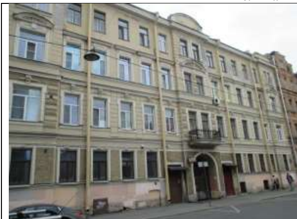
Фото 1. Вид здания, в котором расположен Объект оценки
