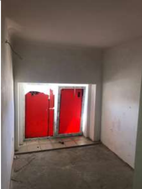
Фото 17. Внутреннее состояние Объекта оценки
