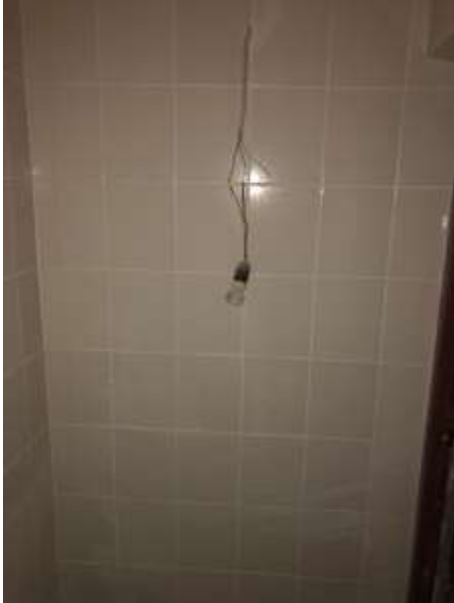
Фото 15. Внутреннее состояние Объекта оценки
