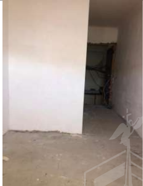
Фото 18. Внутреннее состояние Объекта оценки
