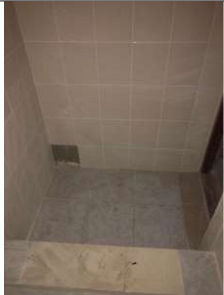
Фото 14. Внутреннее состояние Объекта оценки
