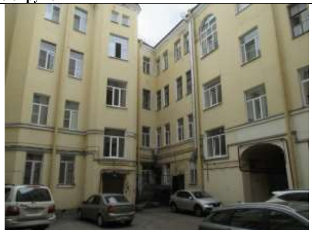
Фото 2. Вид здания, в котором расположен Объект оценки
