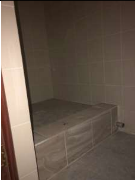
Фото 13. Внутреннее состояние Объекта оценки
