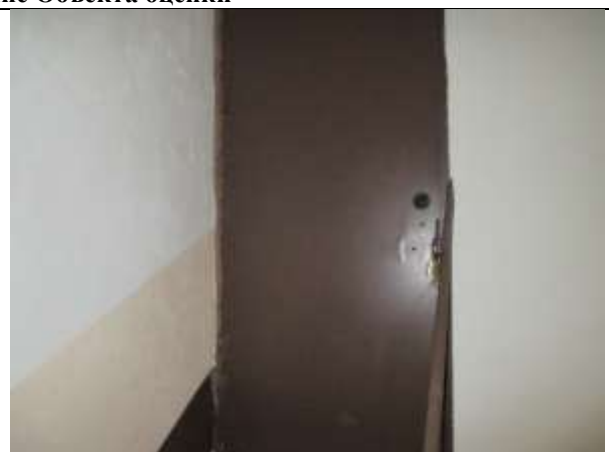
Фото 10. Вход Объекта оценки
