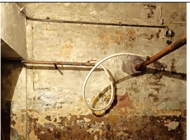
Фото 14. Типичное состояние Объекта оценки
