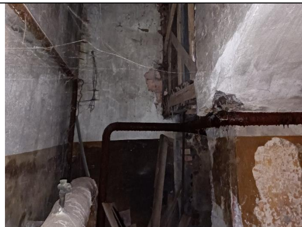
Фото 18. Типичное состояние Объекта оценки
