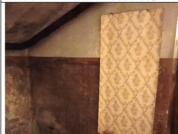
Фото 19. Типичное состояние Объекта оценки
