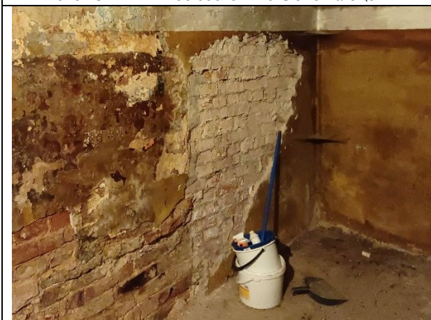
Фото 15. Типичное состояние Объекта оценки
