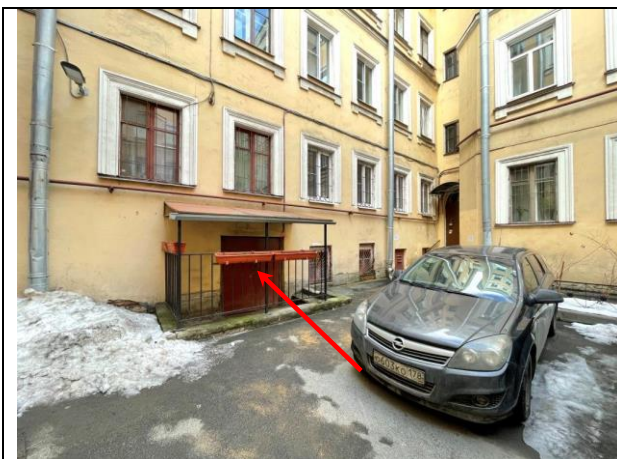
Фото 21. Входная и оконная группа Объекта оценки
