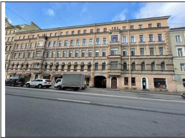
Фото 13. Вид здания Объекта оценки
