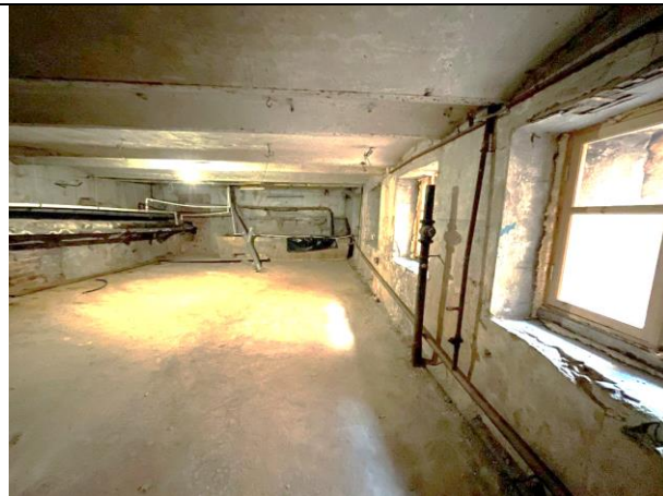
Фото 31. Типичное состояние Объекта оценки
