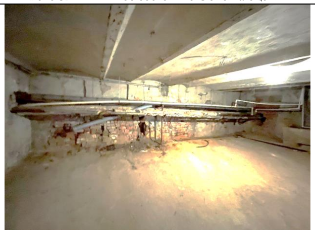
Фото 34. Типичное состояние Объекта оценки
