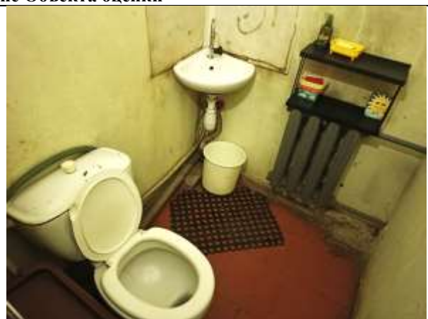
Фото 14. Внутреннее состояние Объекта оценки
