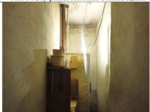
Фото 16. Внутреннее состояние Объекта оценки
