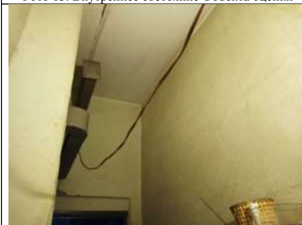
Фото 15. Внутреннее состояние Объекта оценки
