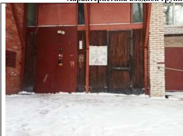
Фото 7. Общий вход Объекта оценки со двора
