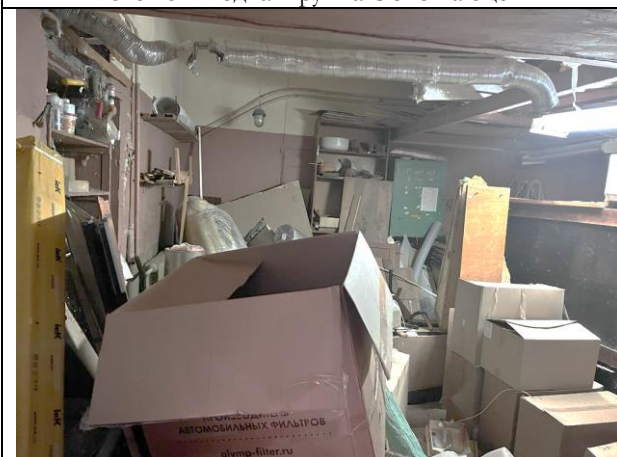
Фото 17. Типичное состояние Объекта оценки
