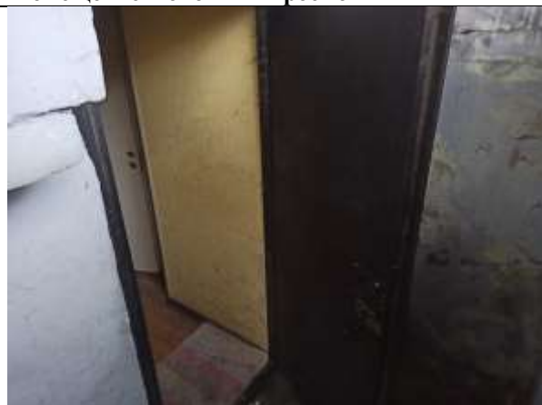
Фото 6. Отдельный вход и окно Объекта оценки со двора
