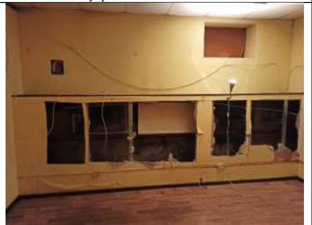
Фото 12. Внутреннее состояние Объекта оценки
