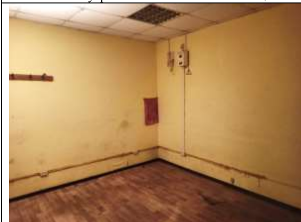
Фото 13. Внутреннее состояние Объекта оценки
