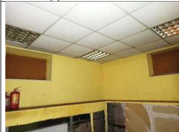
Фото 11. Внутреннее состояние Объекта оценки
