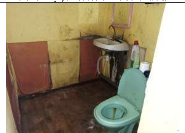
Фото 20. Внутреннее состояние Объекта оценки
