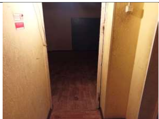
Фото 18. Внутреннее состояние Объекта оценки
