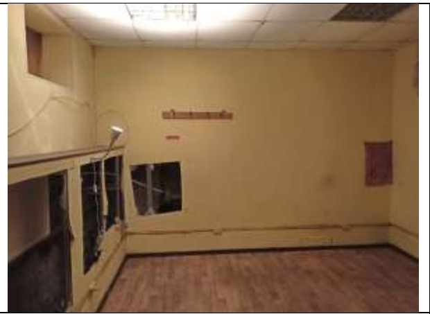
Фото 10. Внутреннее состояние Объекта оценки
