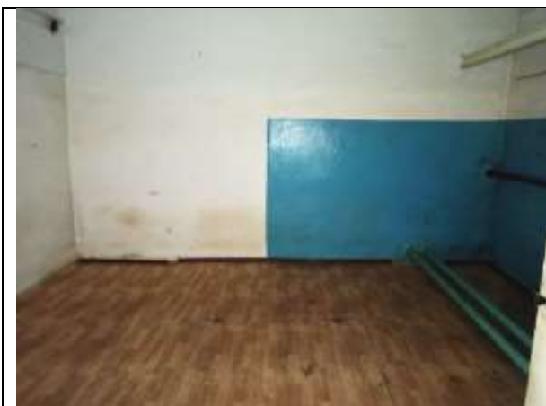
Фото 17. Внутреннее состояние Объекта оценки
