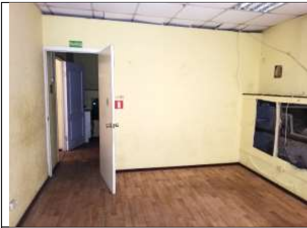
Фото 9. Внутреннее состояние Объекта оценки
