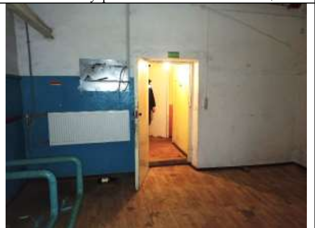
Фото 14. Внутреннее состояние Объекта оценки
