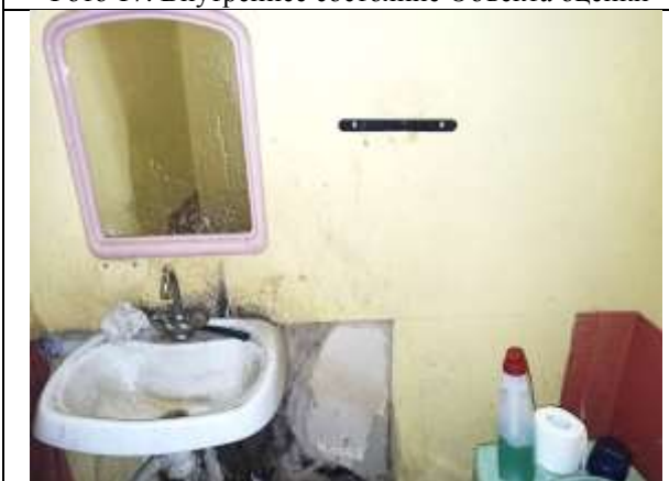
Фото 19. Внутреннее состояние Объекта оценки
