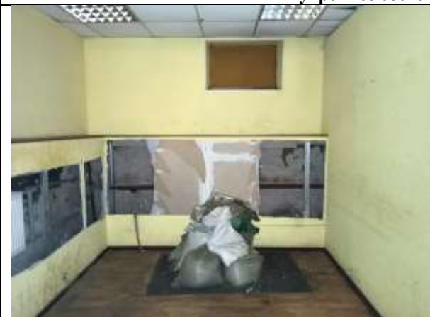
Фото 7. Внутреннее состояние Объекта оценки
