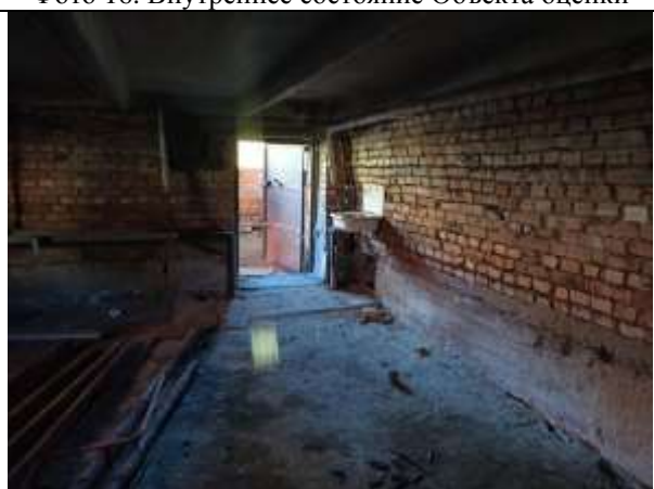
Фото 18. Внутреннее состояние Объекта оценки
