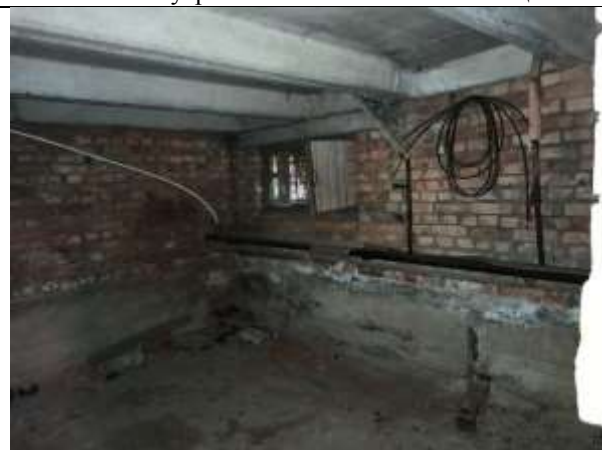
Фото 15. Внутреннее состояние Объекта оценки
