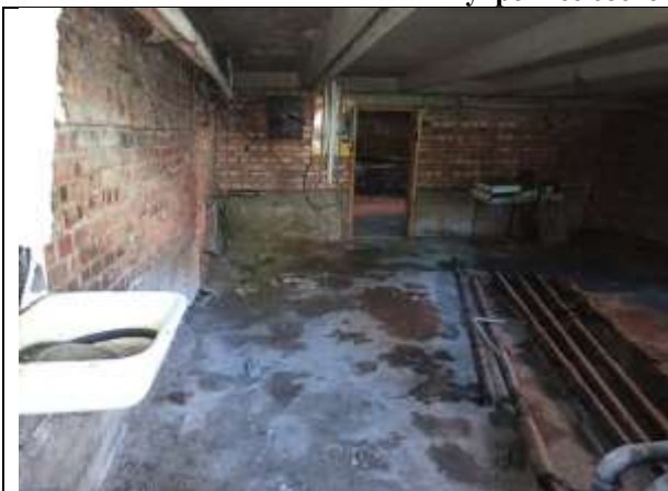
Фото 9. Внутреннее состояние Объекта оценки
