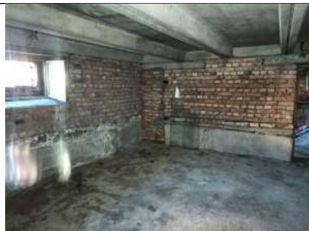
Фото 13. Внутреннее состояние Объекта оценки
