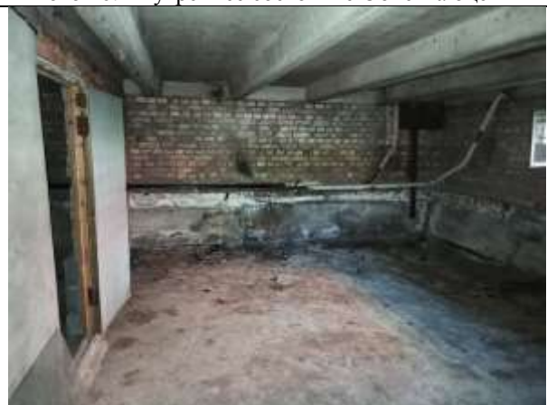
Фото 12. Внутреннее состояние Объекта оценки
