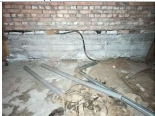
Фото 16. Внутреннее состояние Объекта оценки
