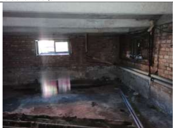
Фото 10. Внутреннее состояние Объекта оценки
