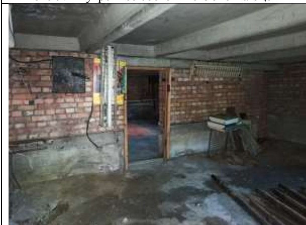
Фото 11. Внутреннее состояние Объекта оценки
