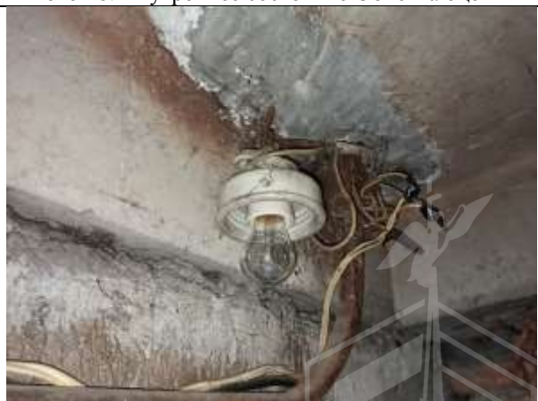
Фото 20. Внутреннее состояние Объекта оценки
