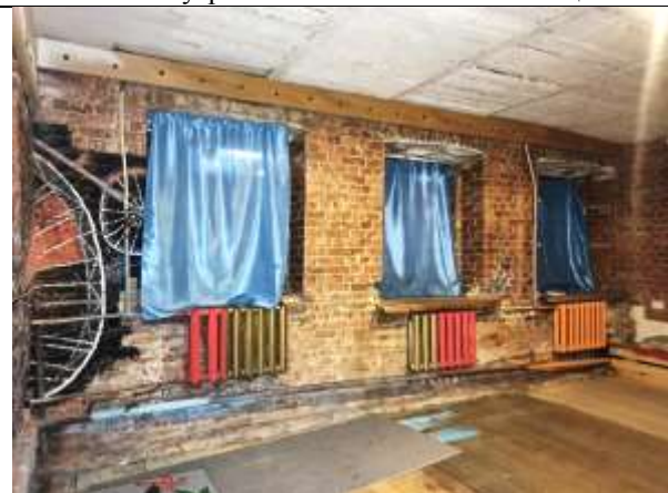
Фото 11. Внутреннее состояние Объекта оценки
