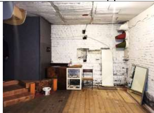
Фото 7. Внутреннее состояние Объекта оценки
