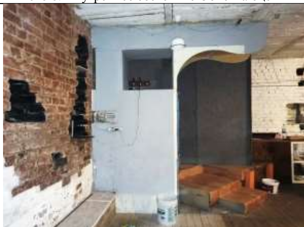
Фото 10. Внутреннее состояние Объекта оценки
