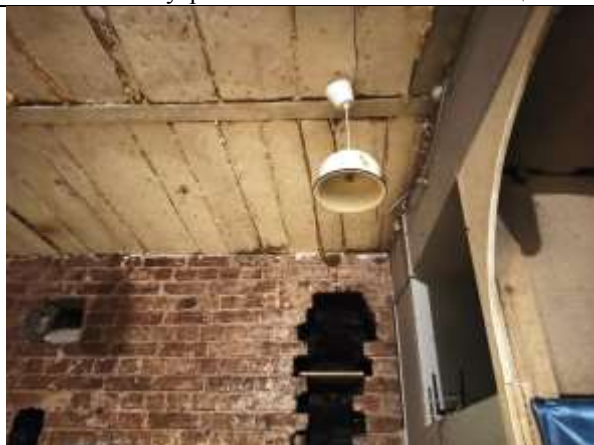
Фото 12. Внутреннее состояние Объекта оценки
