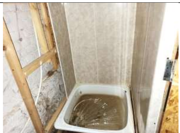
Фото 14. Внутреннее состояние Объекта оценки
