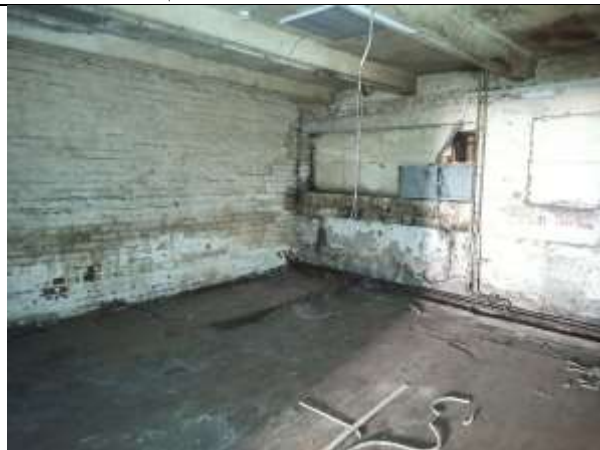
Фото 8. Внутреннее состояние Объекта оценки
