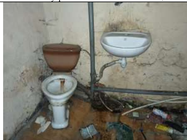
Фото 9. Внутреннее состояние Объекта оценки
