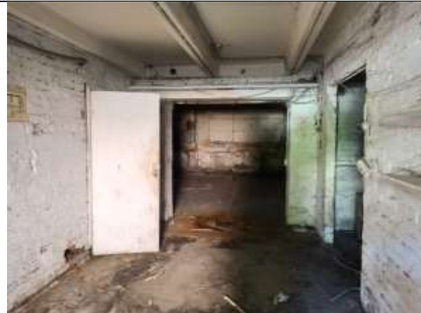
Фото 11. Внутреннее состояние Объекта оценки
