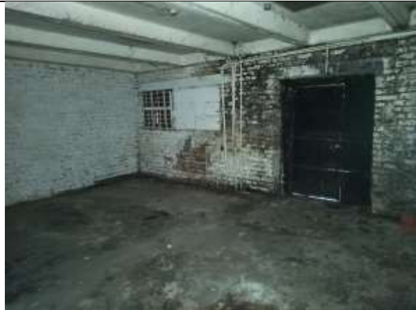
Фото 12. Внутреннее состояние Объекта оценки
