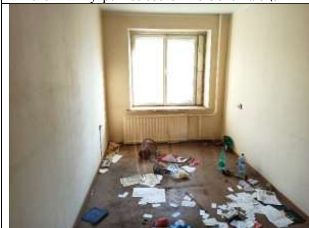
Фото 43. Внутреннее состояние Объекта оценки
