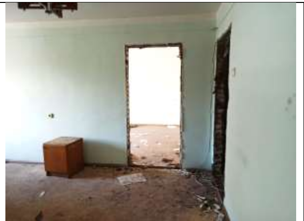
Фото 46. Внутреннее состояние Объекта оценки
