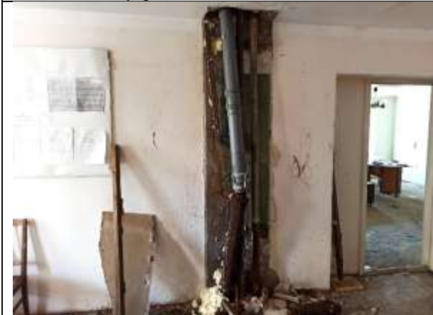
Фото 51. Внутреннее состояние Объекта оценки
