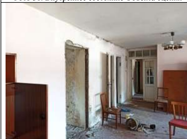
Фото 33. Внутреннее состояние Объекта оценки
