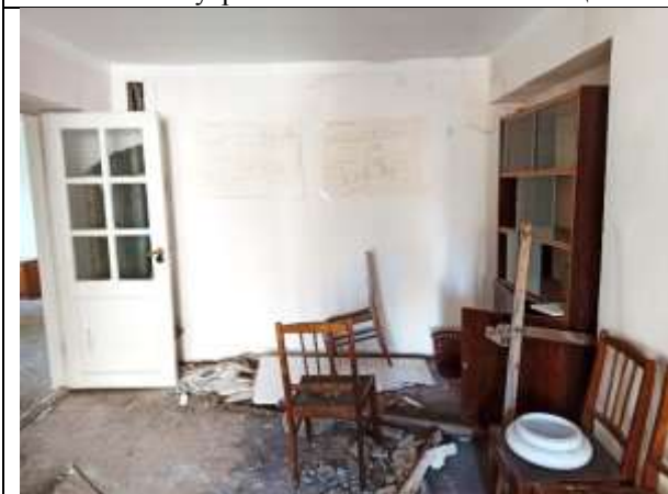
Фото 39. Внутреннее состояние Объекта оценки
