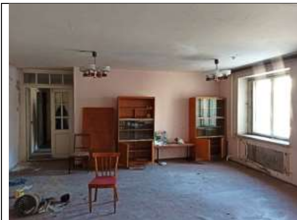
Фото 29. Внутреннее состояние Объекта оценки
