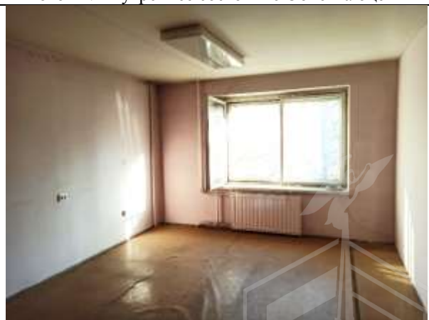
Фото 44. Внутреннее состояние Объекта оценки
