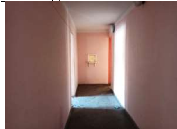
Фото 17. Внутреннее состояние Объекта оценки
