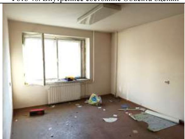
Фото 42. Внутреннее состояние Объекта оценки
