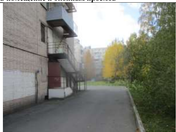
Фото 8. Доступ Объекта оценки – отдельный вход со двора
