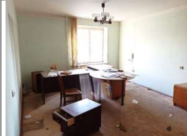
Фото 47. Внутреннее состояние Объекта оценки
