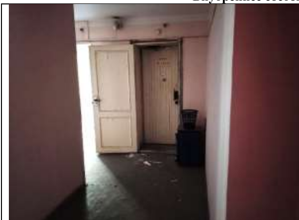
Фото 15. Внутреннее состояние Объекта оценки
