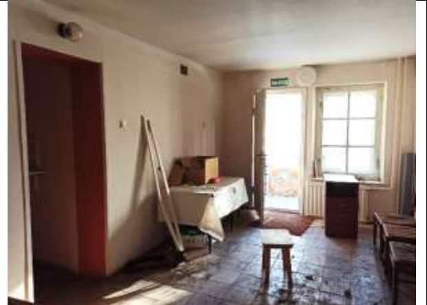
Фото 48. Внутреннее состояние Объекта оценки
