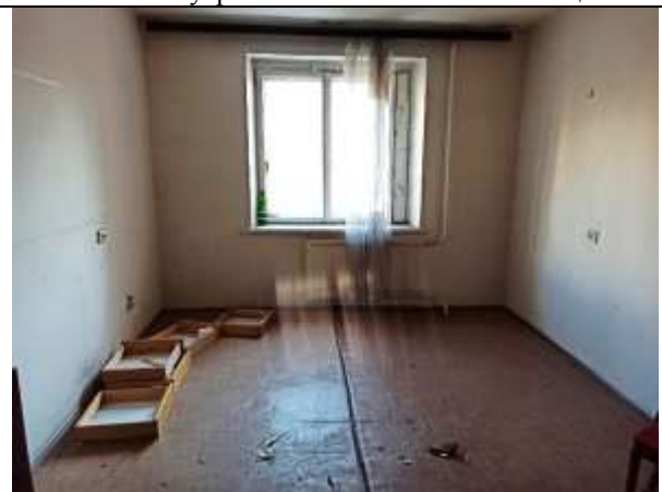
Фото 34. Внутреннее состояние Объекта оценки
