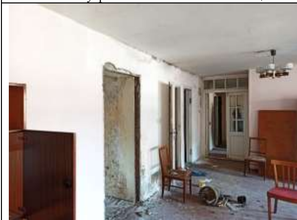
Фото 33. Внутреннее состояние Объекта оценки
