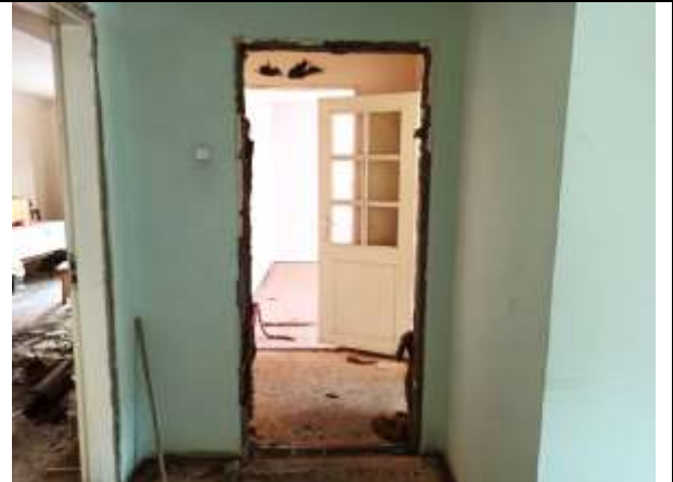
Фото 50. Внутреннее состояние Объекта оценки
