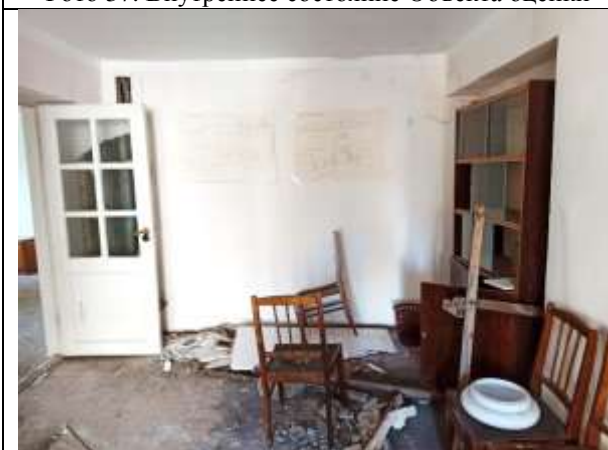
Фото 39. Внутреннее состояние Объекта оценки
