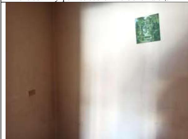
Фото 35. Внутреннее состояние Объекта оценки
