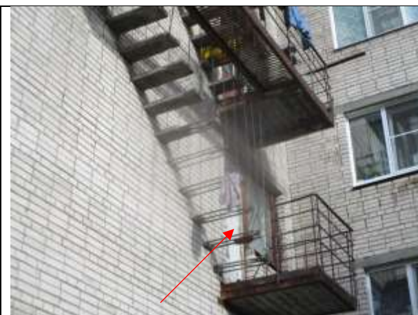
Фото 9. Доступ Объекта оценки – вход с пожарной лестницы
