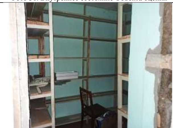
Фото 32. Внутреннее состояние Объекта оценки
