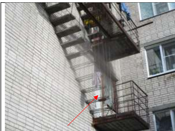
Фото 9. Доступ Объекта оценки – вход с пожарной лестницы
