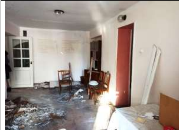
Фото 49. Внутреннее состояние Объекта оценки
