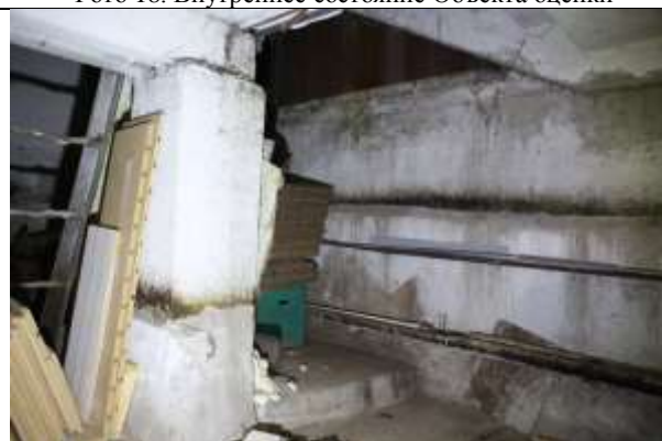
Фото 20. Внутреннее состояние Объекта оценки
