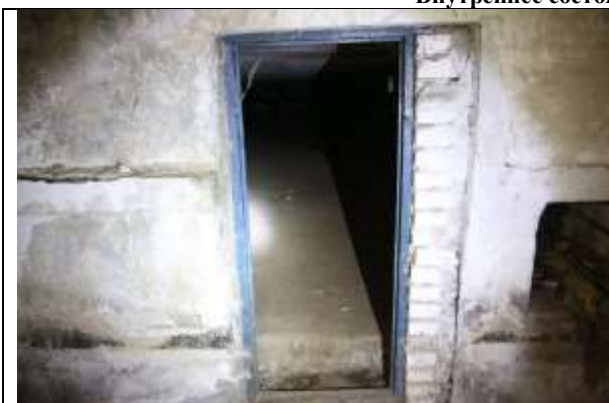
Фото 11. Внутреннее состояние Объекта оценки
