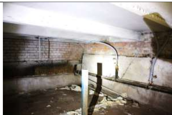
Фото 15. Внутреннее состояние Объекта оценки
