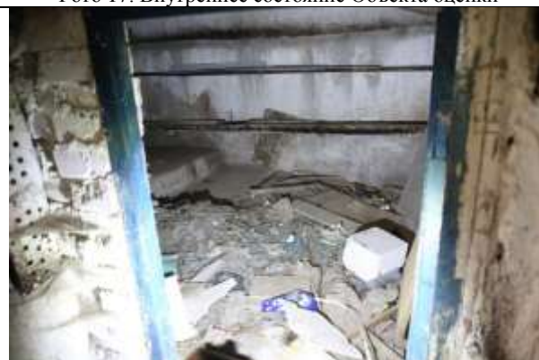
Фото 19. Внутреннее состояние Объекта оценки
