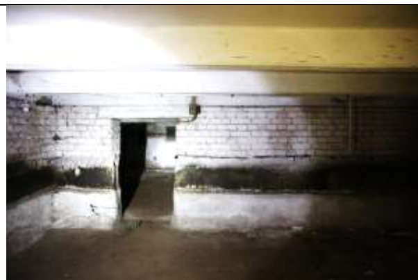
Фото 16. Внутреннее состояние Объекта оценки
