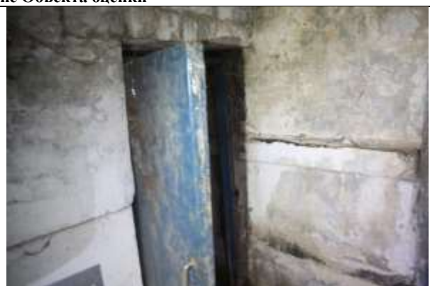
Фото 12. Внутреннее состояние Объекта оценки
