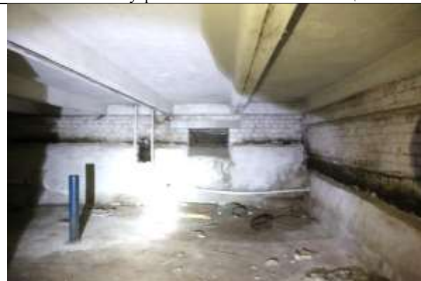
Фото 17. Внутреннее состояние Объекта оценки
