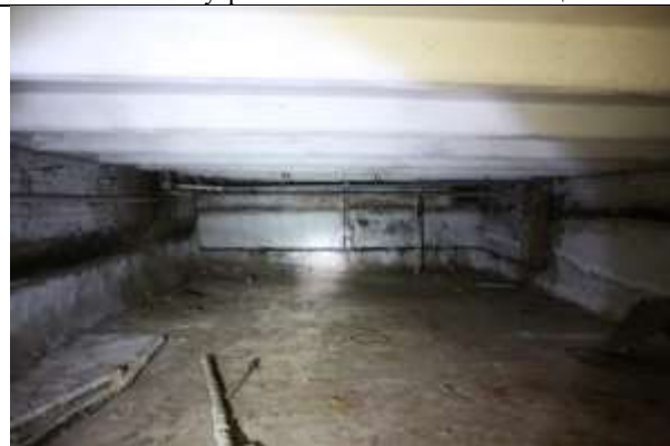
Фото 18. Внутреннее состояние Объекта оценки
