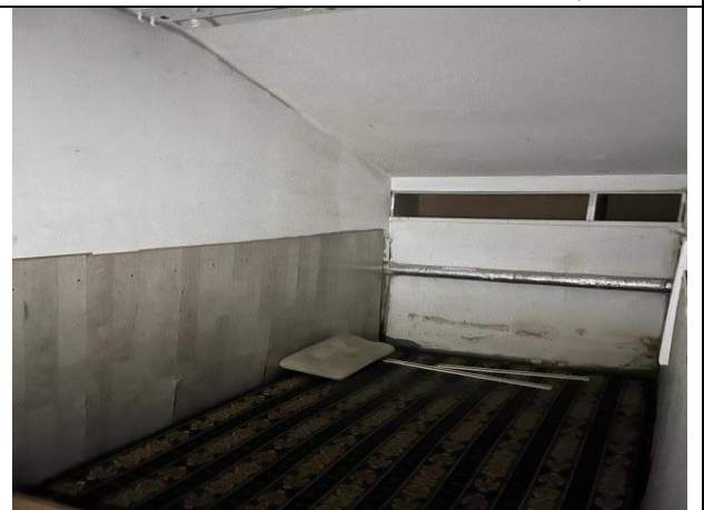
Фото 24. Типичное состояние Объекта оценки
