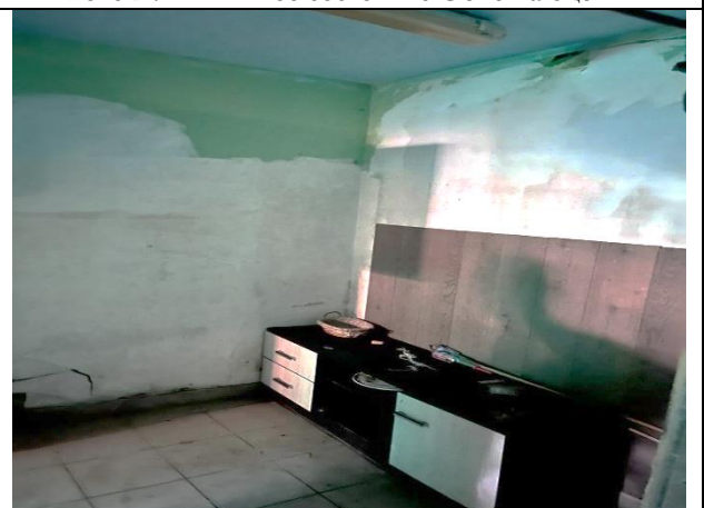
Фото 26. Типичное состояние Объекта оценки
