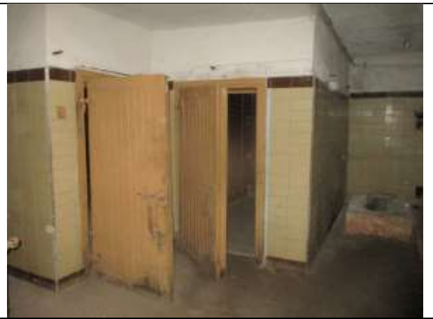
Фото 14. Внутреннее состояние Объекта оценки
