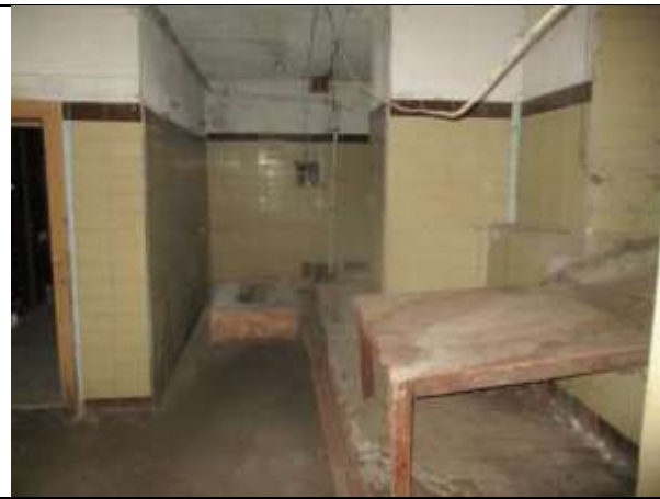
Фото 13. Внутреннее состояние Объекта оценки
