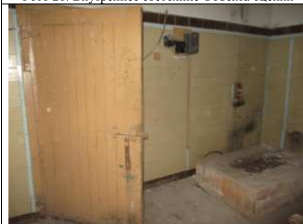
Фото 23. Внутреннее состояние Объекта оценки
