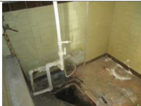
Фото 8. Внутреннее состояние Объекта оценки
