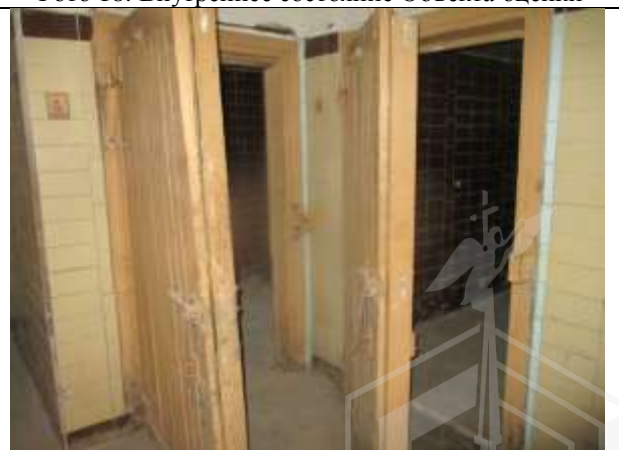
Фото 20. Внутреннее состояние Объекта оценки
