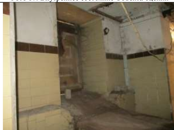
Фото 19. Внутреннее состояние Объекта оценки
