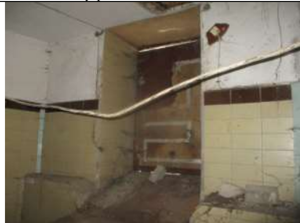
Фото 15. Внутреннее состояние Объекта оценки
