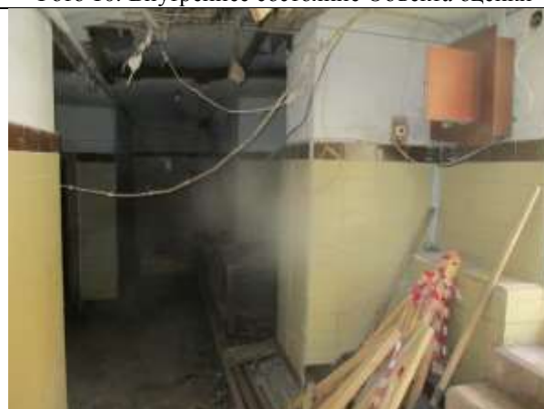
Фото 12. Внутреннее состояние Объекта оценки
