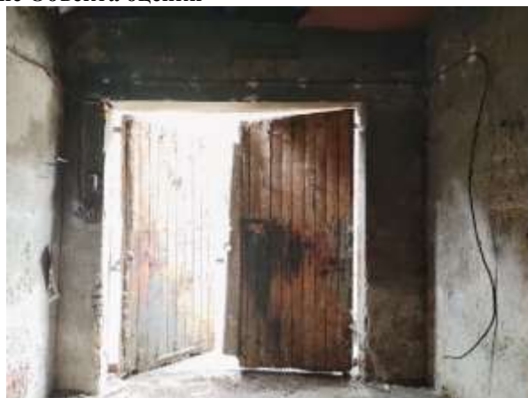
Фото 10. Вход в помещение
