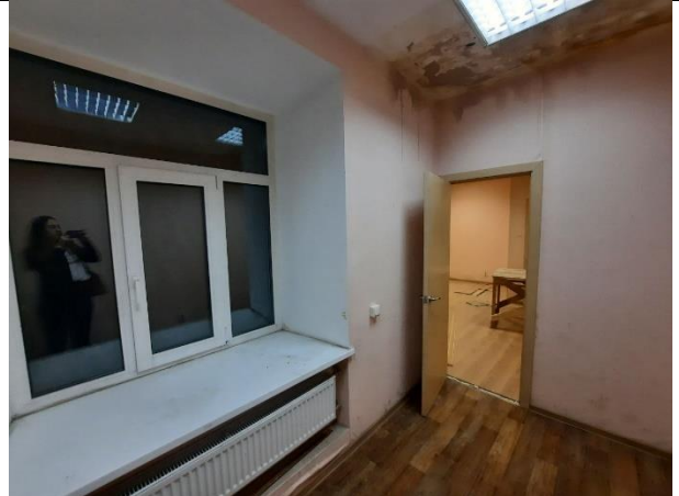
Фото № 26 – Внутреннее состояние помещения
