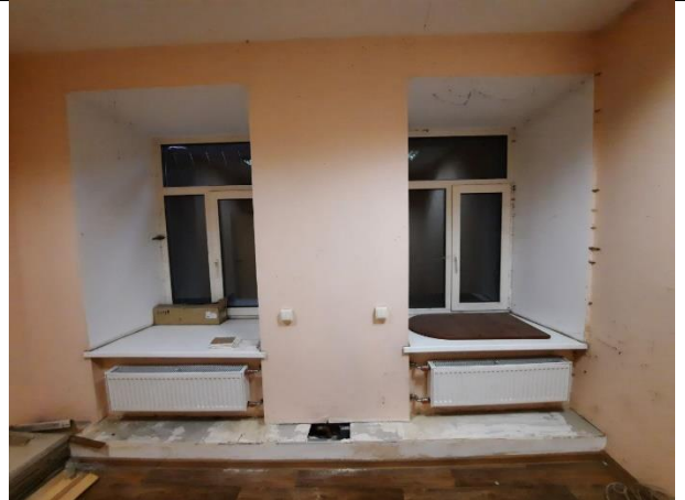
Фото № 18 – Внутреннее состояние помещения
