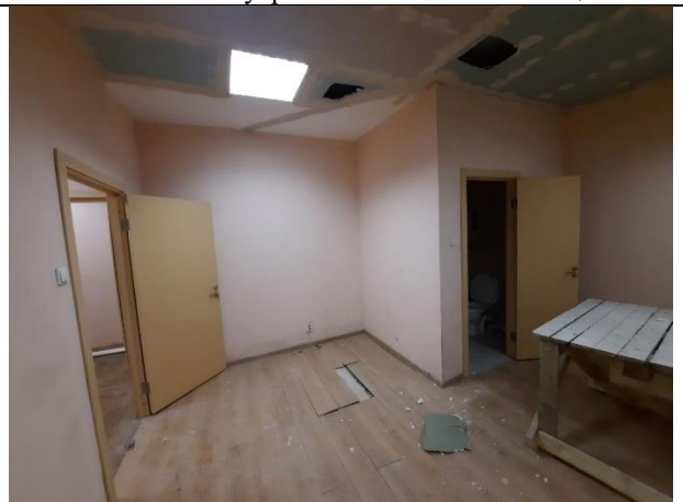
Фото № 20 – Внутреннее состояние помещения
