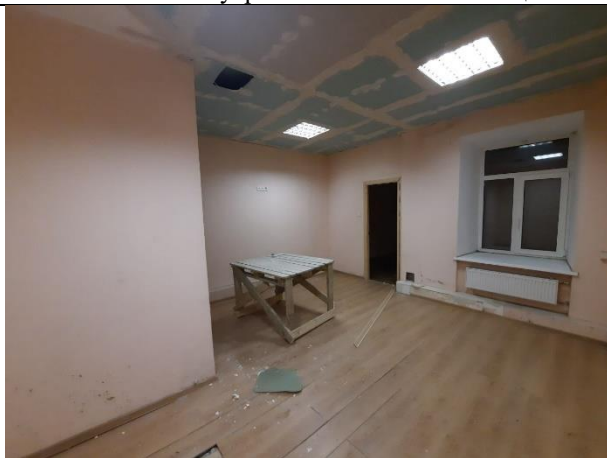
Фото № 19 – Внутреннее состояние помещения
