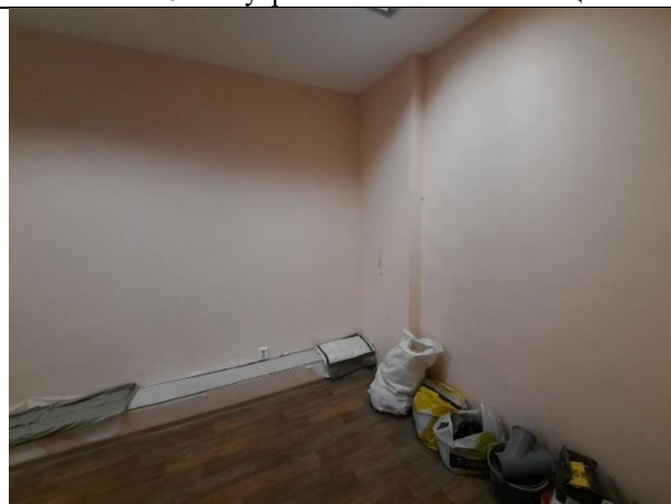
Фото № 12 – Внутреннее состояние помещения
