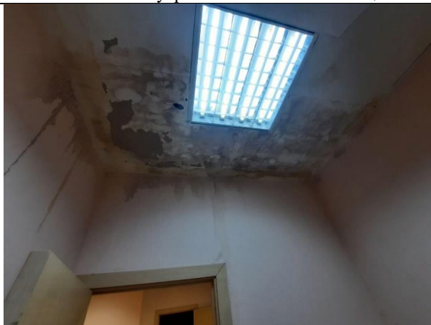
Фото № 27 – Внутреннее состояние помещения
