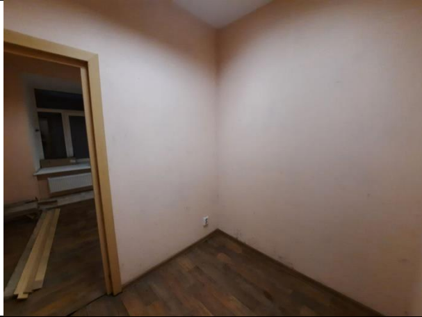
Фото № 15 – Внутреннее состояние помещения
