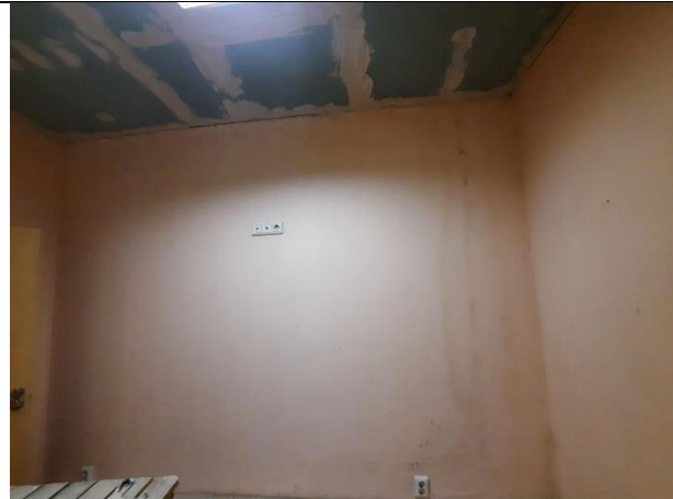
Фото № 23 – Внутреннее состояние помещения
