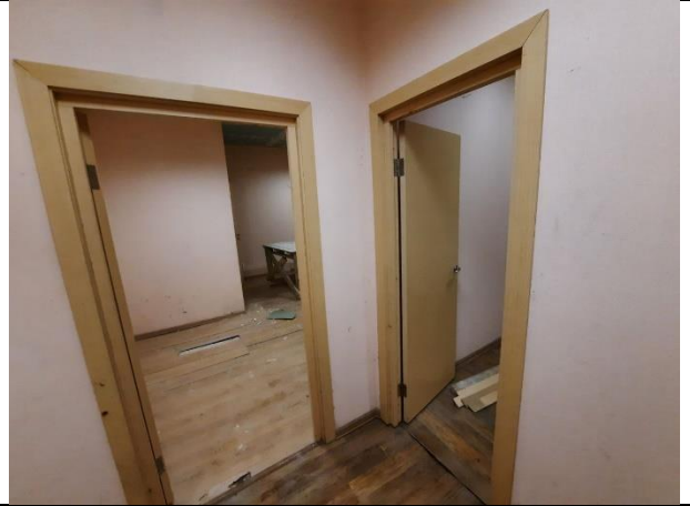
Фото № 16 – Внутреннее состояние помещения
