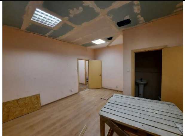
Фото № 24 – Внутреннее состояние помещения
