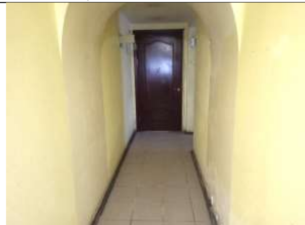
Фото 10. Внутреннее состояние Объекта оценки
