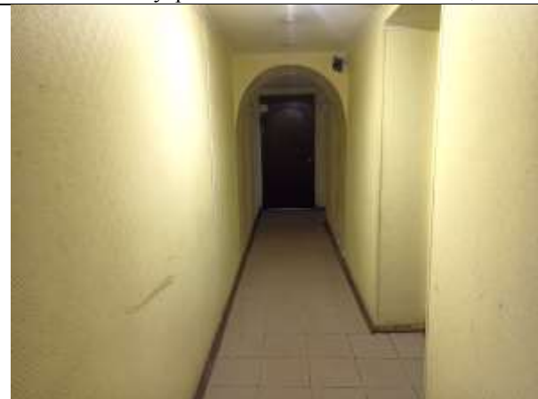
Фото 12. Внутреннее состояние Объекта оценки
