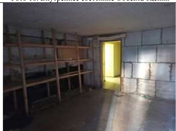
Фото 20. Внутреннее состояние Объекта оценки
