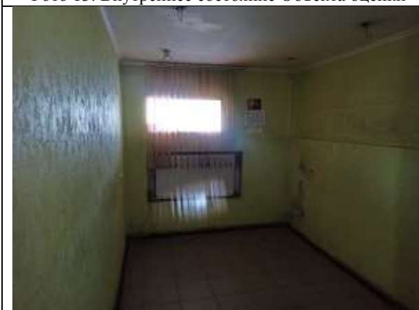
Фото 17. Внутреннее состояние Объекта оценки
