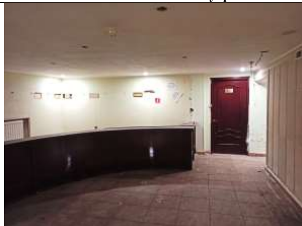
Фото 9. Внутреннее состояние Объекта оценки
