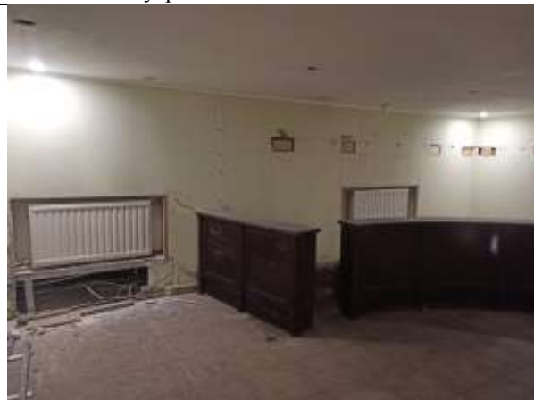
Фото 11. Внутреннее состояние Объекта оценки
