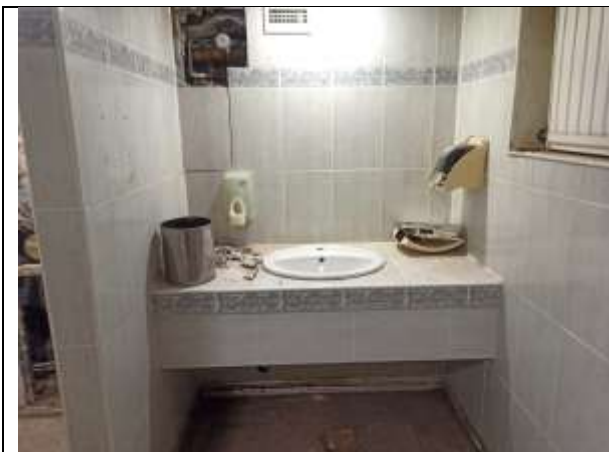
Фото 15. Внутреннее состояние Объекта оценки
