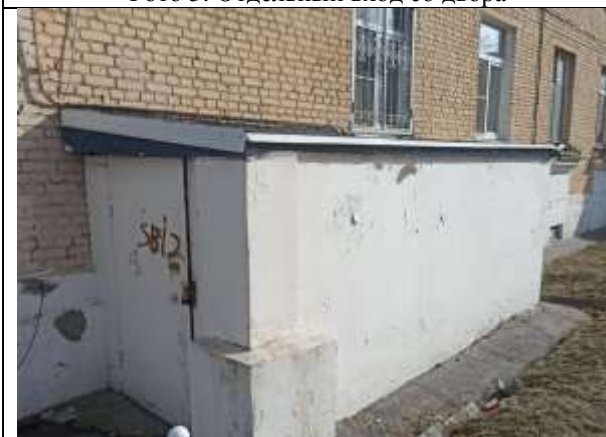
Фото 7. Отдельный вход с улицы
