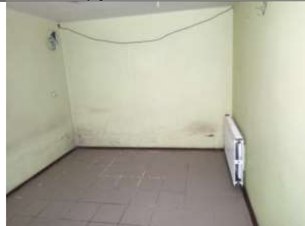
Фото 14. Внутреннее состояние Объекта оценки
