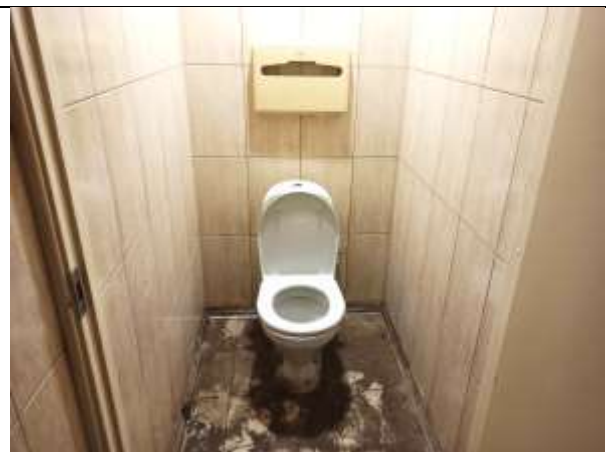
Фото 16. Внутреннее состояние Объекта оценки
