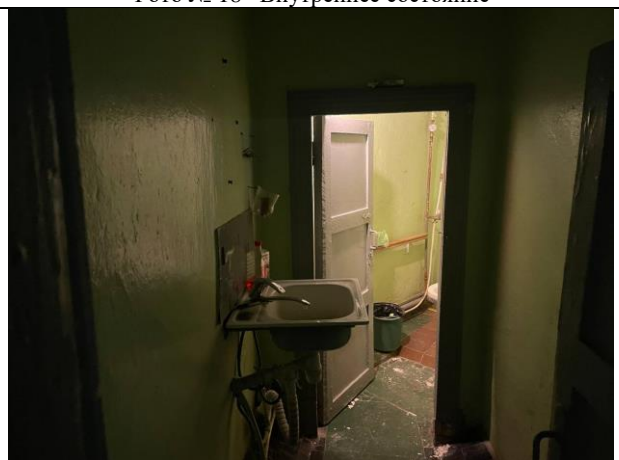
Фото № 20– Внутреннее состояние
