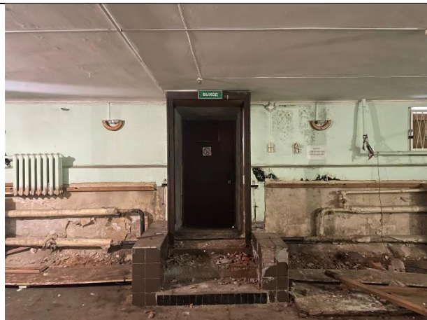
Фото № 24– Внутреннее состояние
