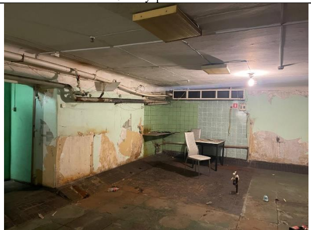
Фото № 18– Внутреннее состояние
