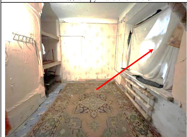
Фото 27. Типичное состояние Объекта оценки, оконная группа Объекта оценки
