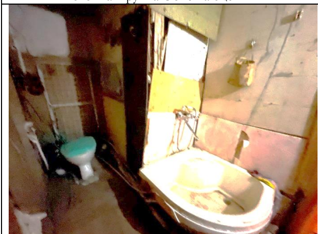
Фото 29. Типичное состояние Объекта оценки
