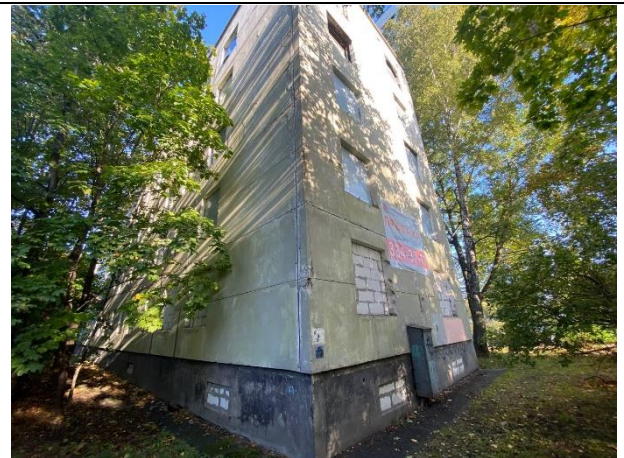
Фото № 14. Внешний вид здания
