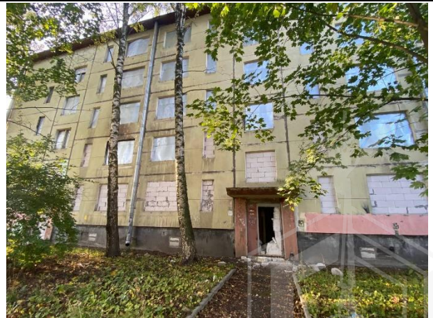
Фото № 8. Внешний вид здания
