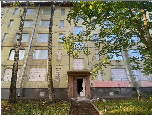
Фото № 7. Внешний вид здания
