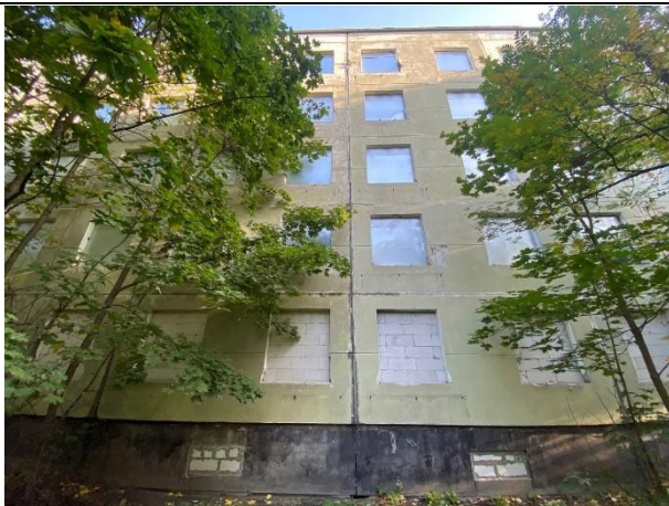
Фото № 13. Внешний вид здания
