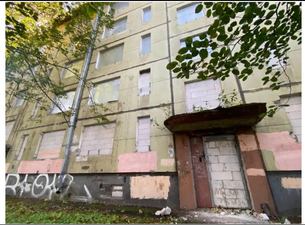
Фото № 10 Внешний вид здания
