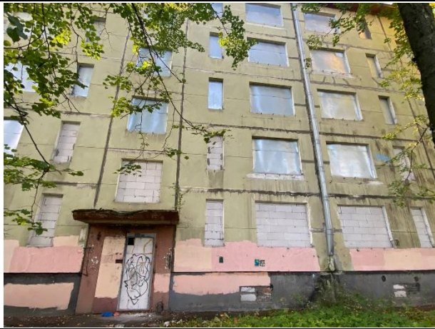
Фото № 9. Внешний вид здания
