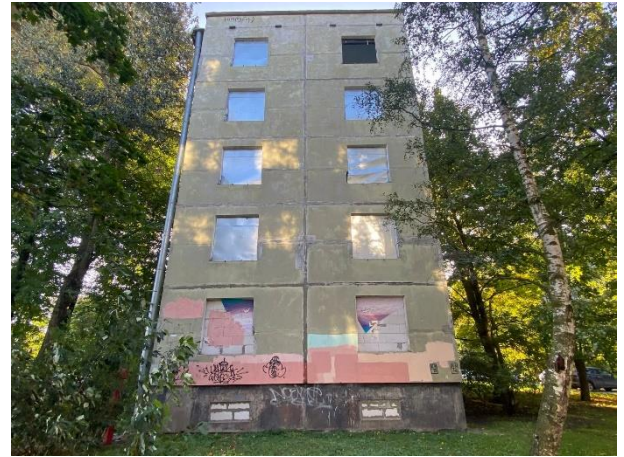
Фото № 12 Внешний вид здания
