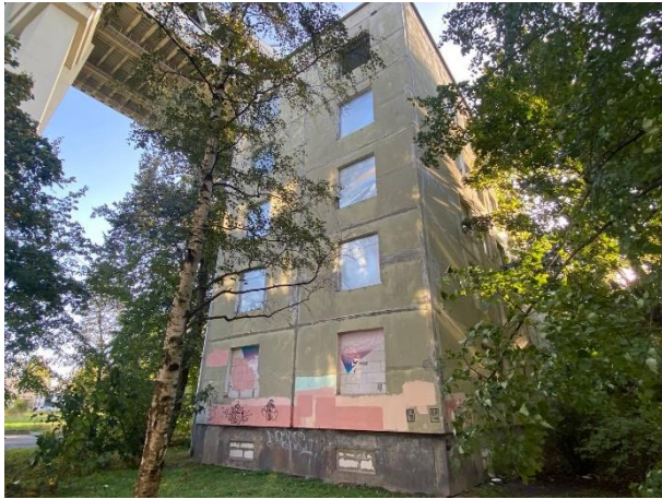
Фото № 11. Внешний вид здания
