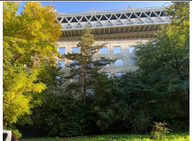
Фото № 6. Внешний вид здания
