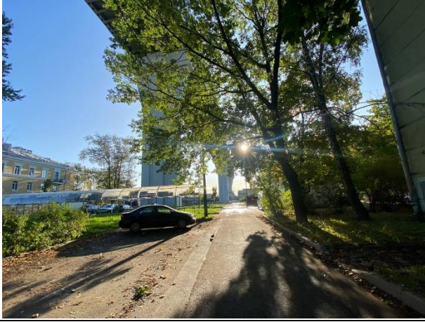
Фото № 1. Подъездные пути и окружение объекта
