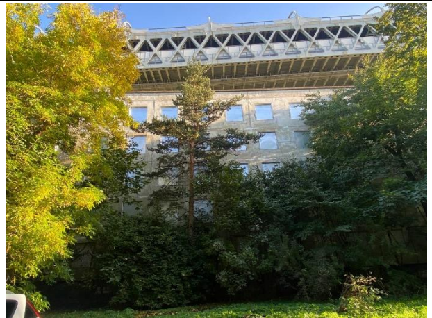
Фото № 6. Внешний вид здания
