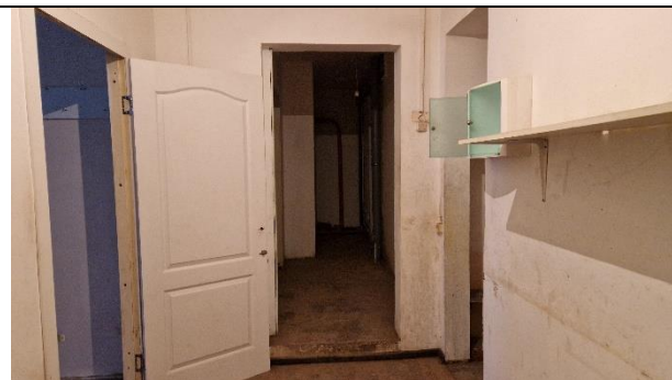
Фото 20. Типичное состояние Объекта оценки
