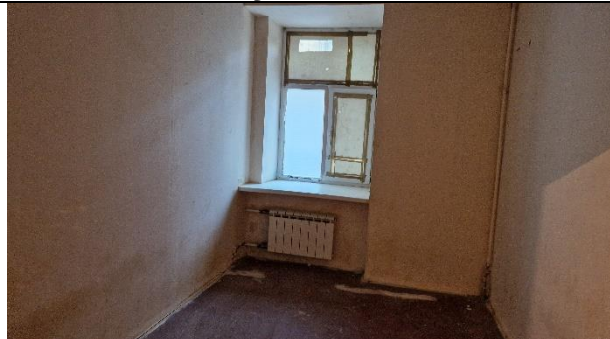
Фото 21. Типичное состояние Объекта оценки
