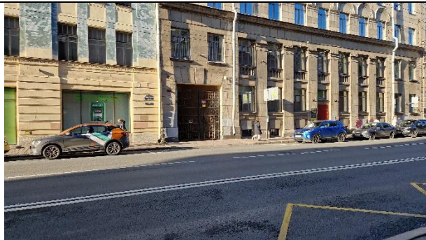
Фото 9. Арка ведущая во двор Объекта оценки (со стороны Загородного проспекта)
