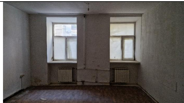
Фото 24. Типичное состояние Объекта оценки
