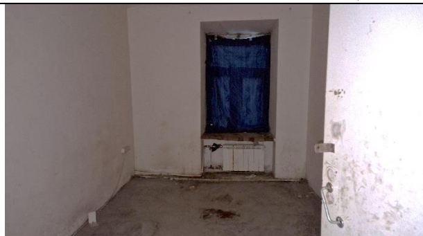
Фото 27. Типичное состояние Объекта оценки
