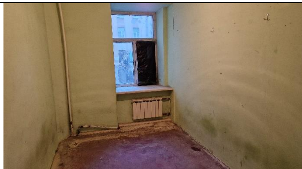
Фото 25. Типичное состояние Объекта оценки
