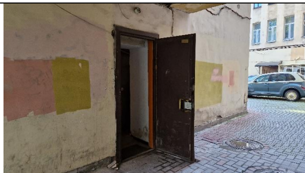
Фото 19. Вид здания расположения Объекта оценки
