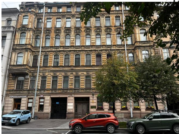
Фото 1. Вид здания Объекта оценки
