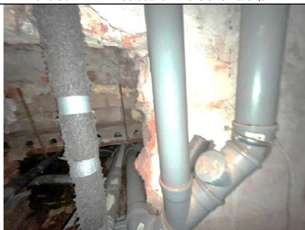
Фото 32. Типичное состояние Объекта оценки
