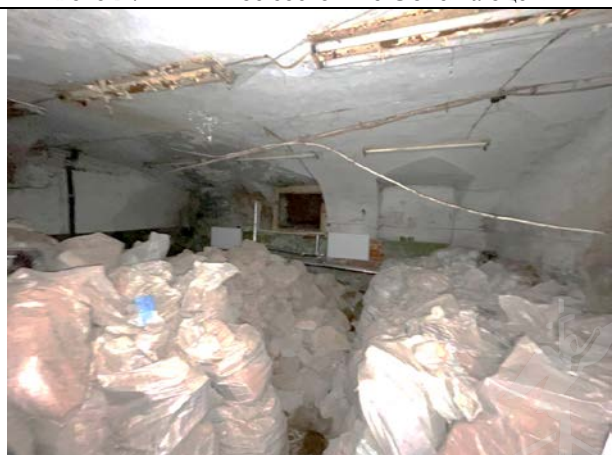
Фото 26. Типичное состояние Объекта оценки
