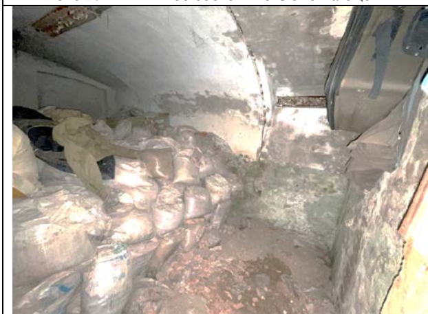
Фото 31. Типичное состояние Объекта оценки
