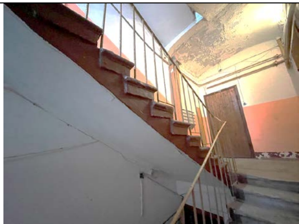
Фото 20. Лестничная клетка Объекта оценки
