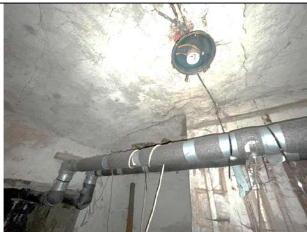
Фото 36. Типичное состояние Объекта оценки
