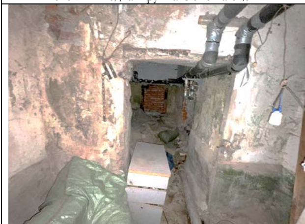
Фото 23. Типичное состояние Объекта оценки
