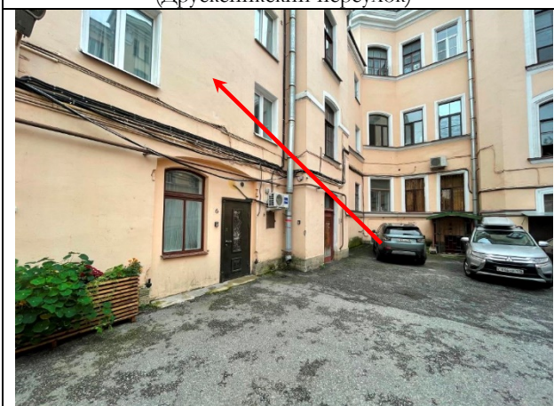
Фото 17. Вид здания расположения Объекта оценки
