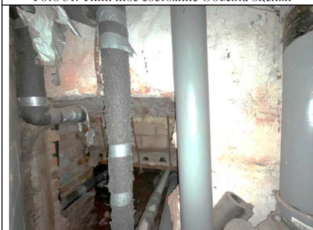
Фото 33. Типичное состояние Объекта оценки
