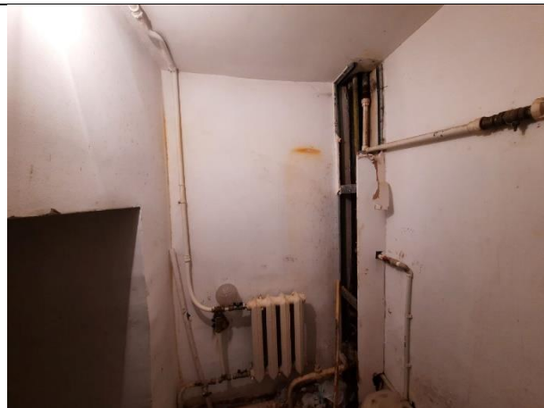
Фото № 26 – Внутреннее состояние помещения
