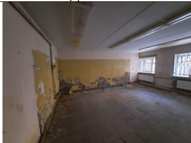
Фото № 30 – Внутреннее состояние помещения
