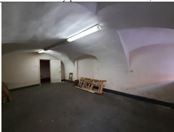
Фото № 21 – Внутреннее состояние помещения
