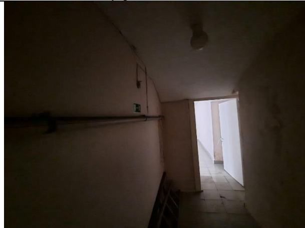
Фото № 28 – Внутреннее состояние помещения
