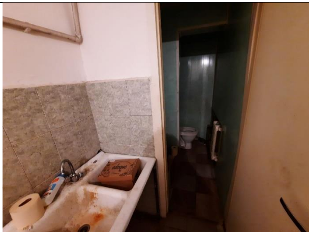
Фото № 25 – Внутреннее состояние помещения
