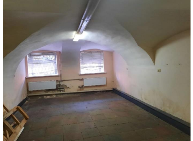
Фото № 20 – Внутреннее состояние помещения
