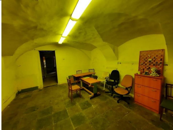
Фото № 19 – Внутреннее состояние помещения
