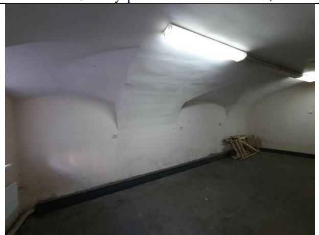
Фото № 22 – Внутреннее состояние помещения
