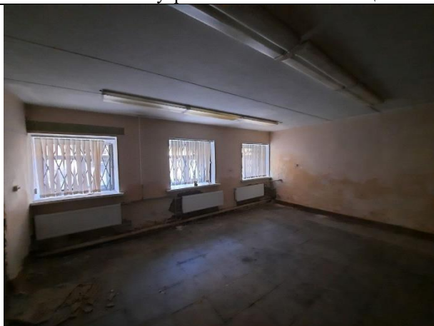
Фото № 31 – Внутреннее состояние помещения
