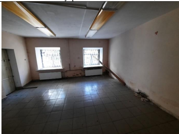
Фото № 29 – Внутреннее состояние помещения
