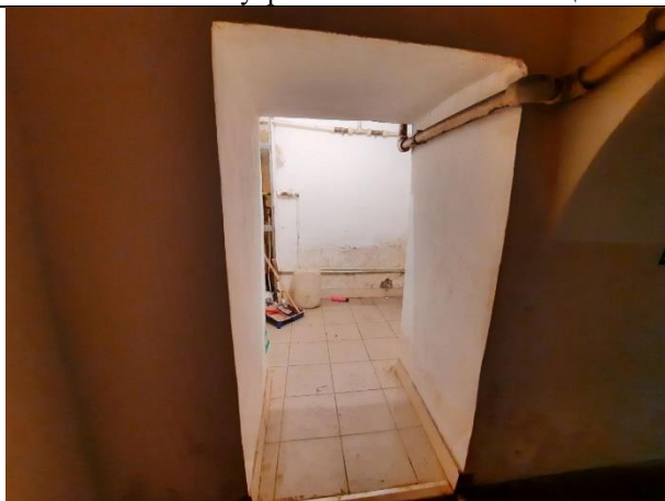
Фото № 23 – Внутреннее состояние помещения
