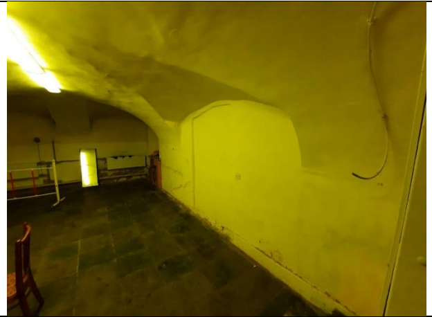
Фото № 18 – Внутреннее состояние помещения
