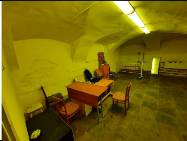
Фото № 17 – Внутреннее состояние помещения
