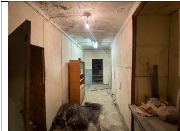
Фото № 9 – Внутреннее состояние помещения
