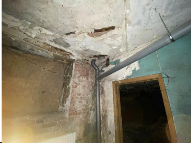
Фото № 17 – Внутреннее состояние помещения
