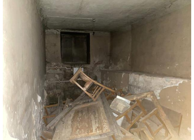
Фото № 20 – Внутреннее состояние помещения
