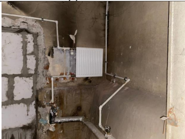
Фото № 21 – Внутреннее состояние помещения
