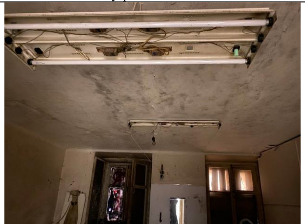
Фото № 22 – Внутреннее состояние помещения
