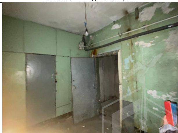
Фото № 8 – Внутреннее состояние помещения
