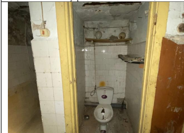
Фото № 11 – Внутреннее состояние помещения
