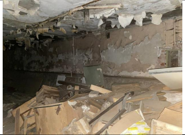
Фото № 18 – Внутреннее состояние помещения
