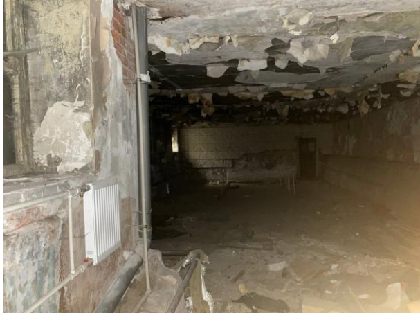
Фото № 19 – Внутреннее состояние помещения
