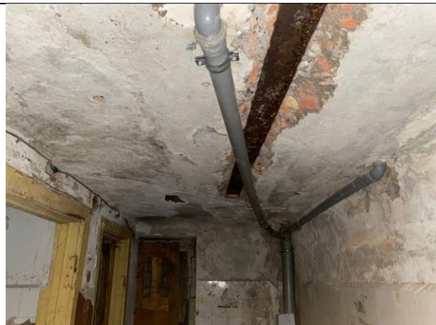
Фото № 10 – Внутреннее состояние помещения
