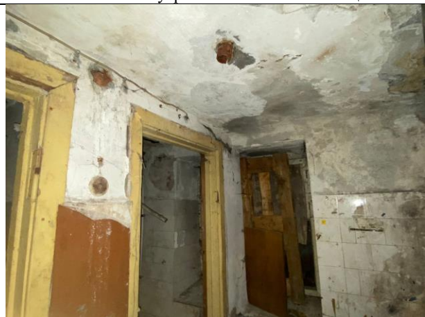
Фото № 12 – Внутреннее состояние помещения
