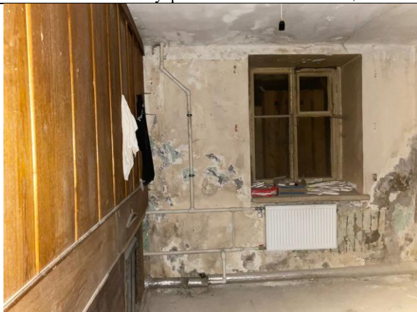
Фото № 23 – Внутреннее состояние помещения
