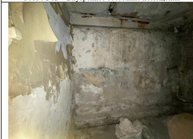
Фото № 15 – Внутреннее состояние помещения
