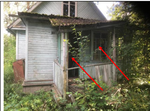
Фото 15. Вид Объекта оценки, входная и оконная группа Объекта оценки
