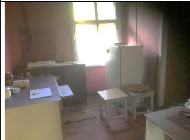
Фото 19. Типичное состояние Объекта оценки
