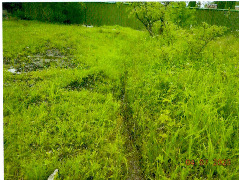
Фото №3. Водоотводная канава, отходящая от колодца, расположенного в границах земельного участка
