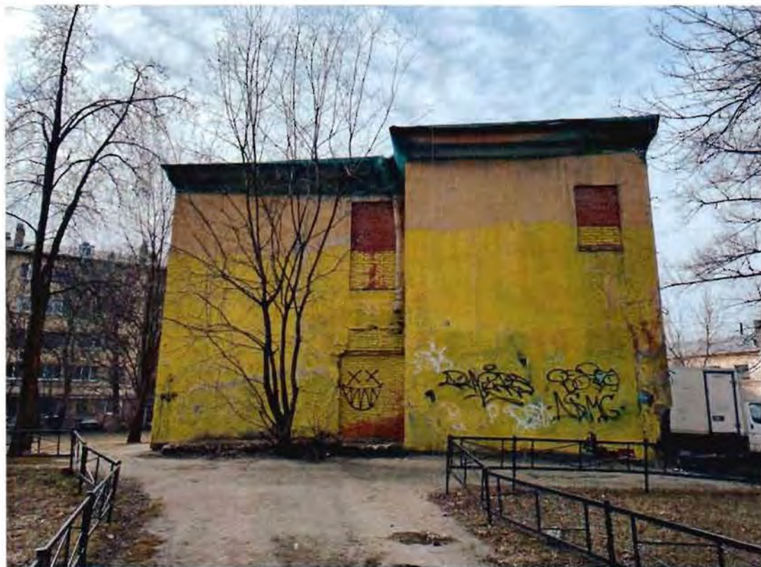
4. Восточный фасад объекта культурного наследия.
