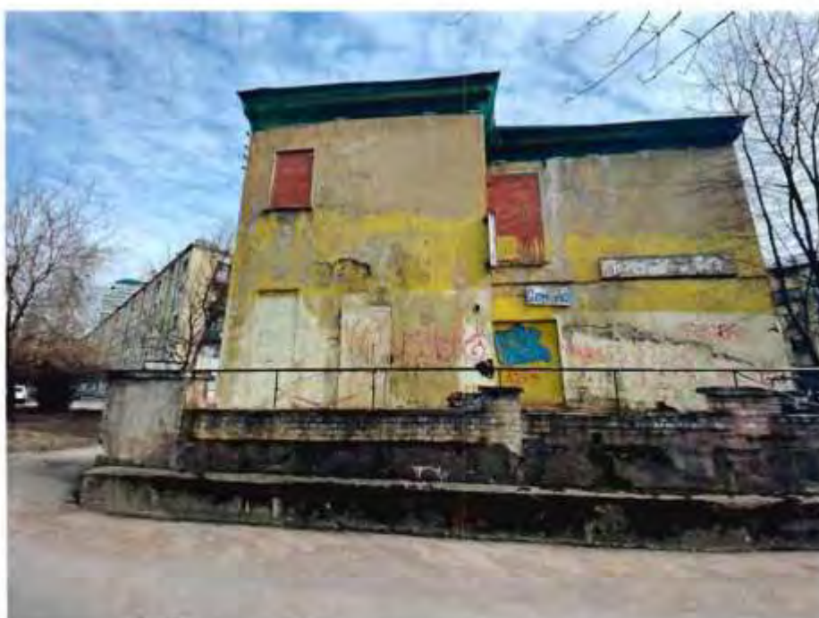
3. Западный фасад объекта культурного наследия.
