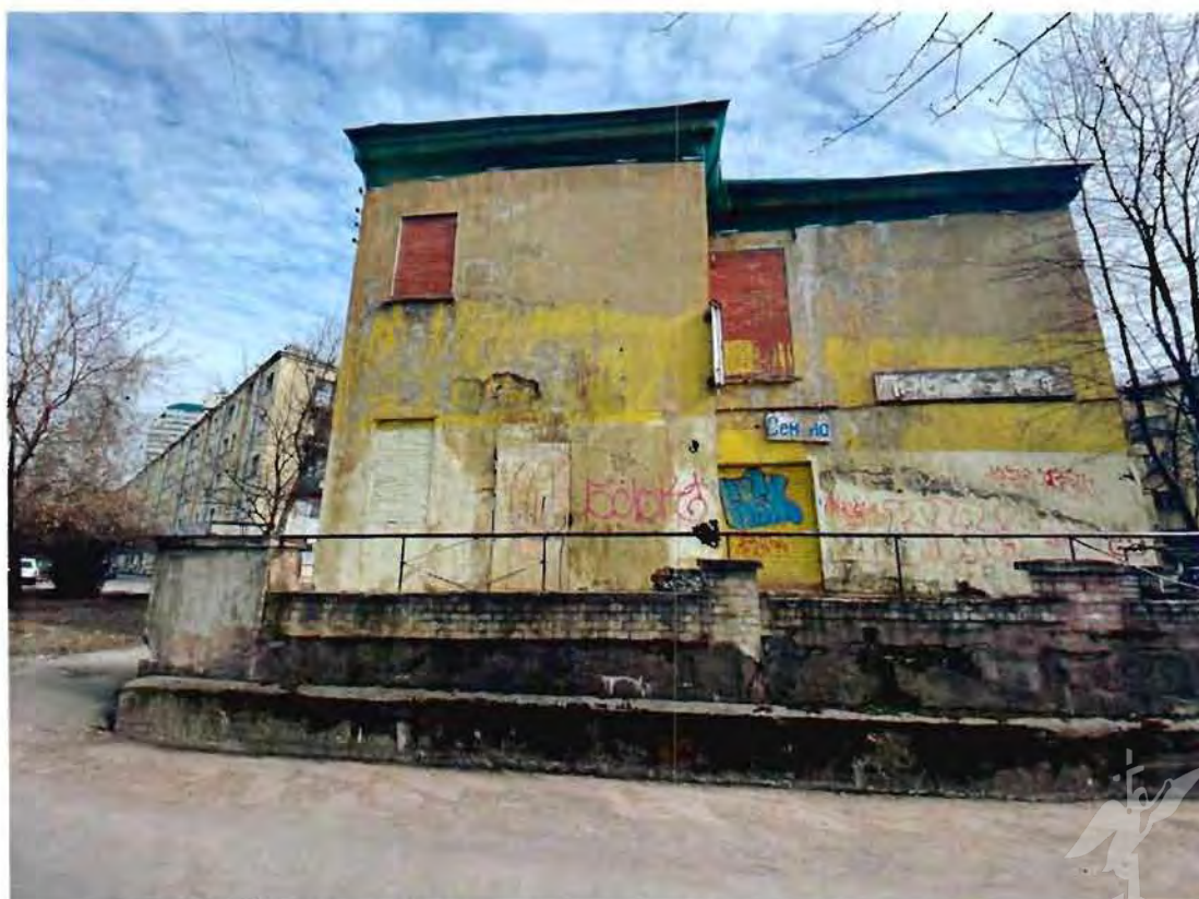
3. Западный фасад объекта культурного наследия.
