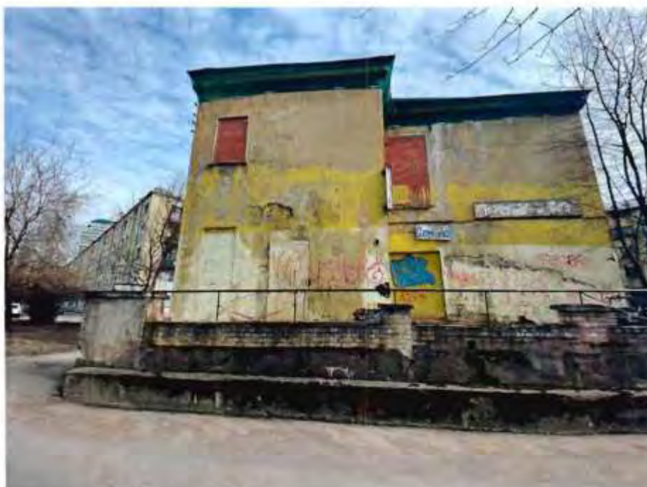
3. Западный фасад объекта культурного наследия.
