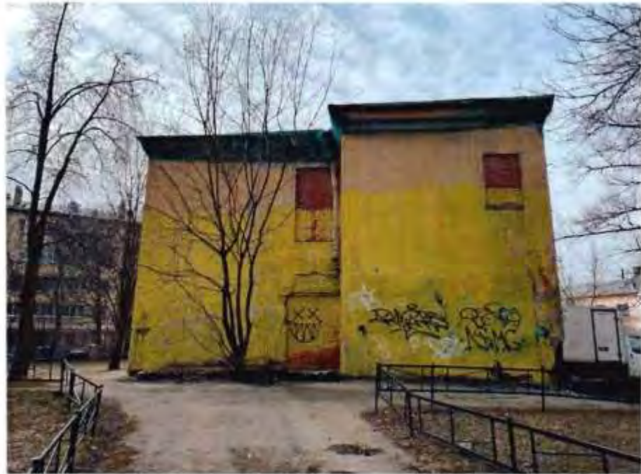
4. Восточный фасад объекта культурного наследия.
