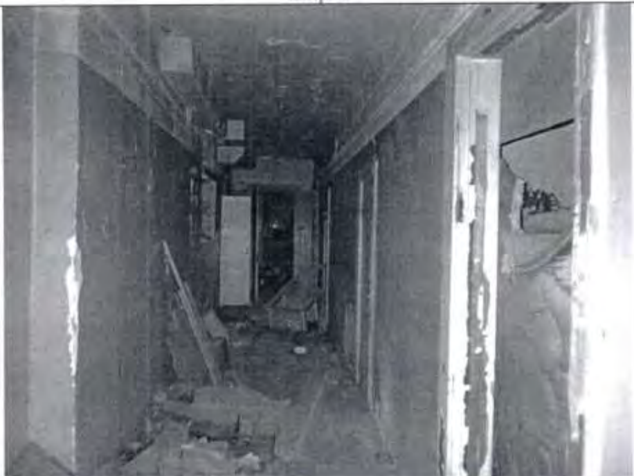
Описание: Вид внутри Объекта.
