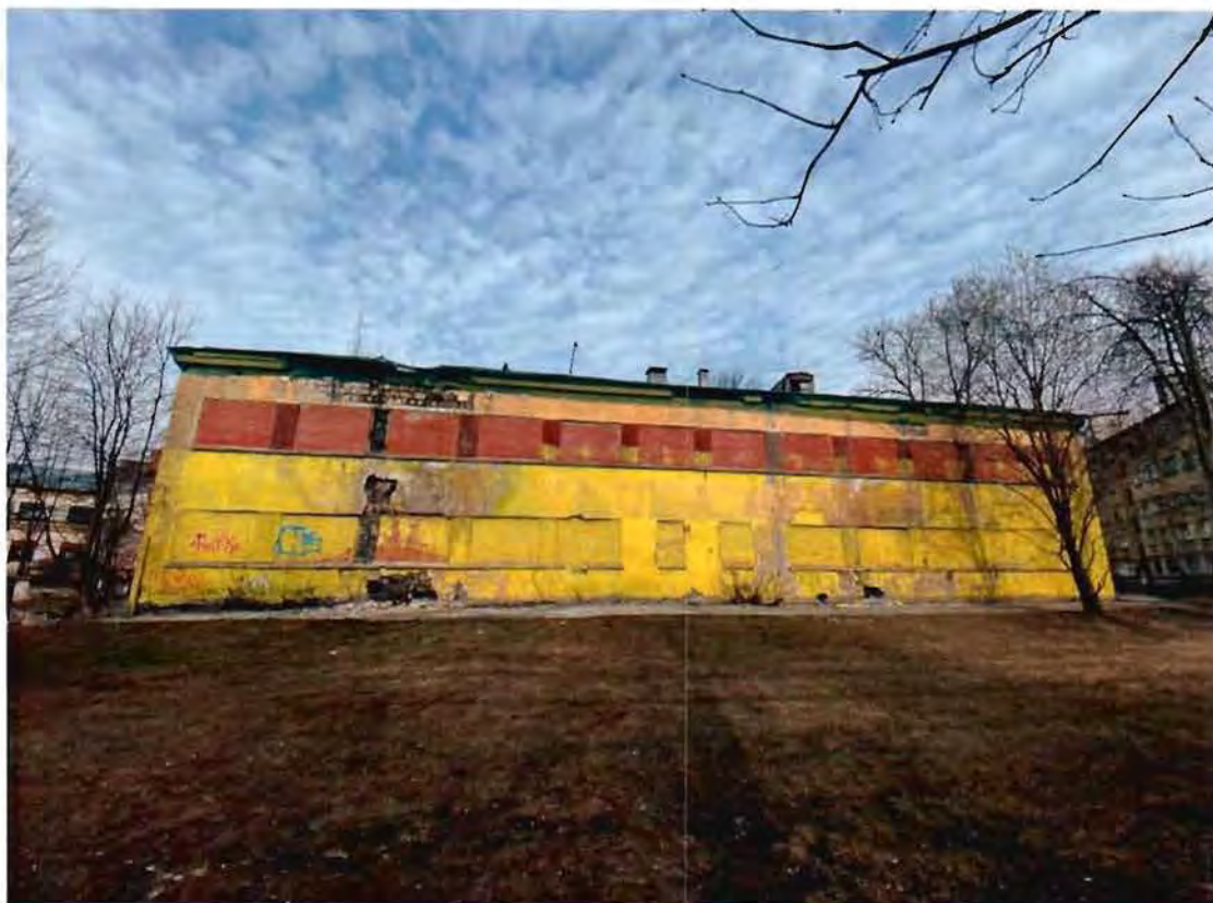
2. Южный фасад объекта культурного наследия.
