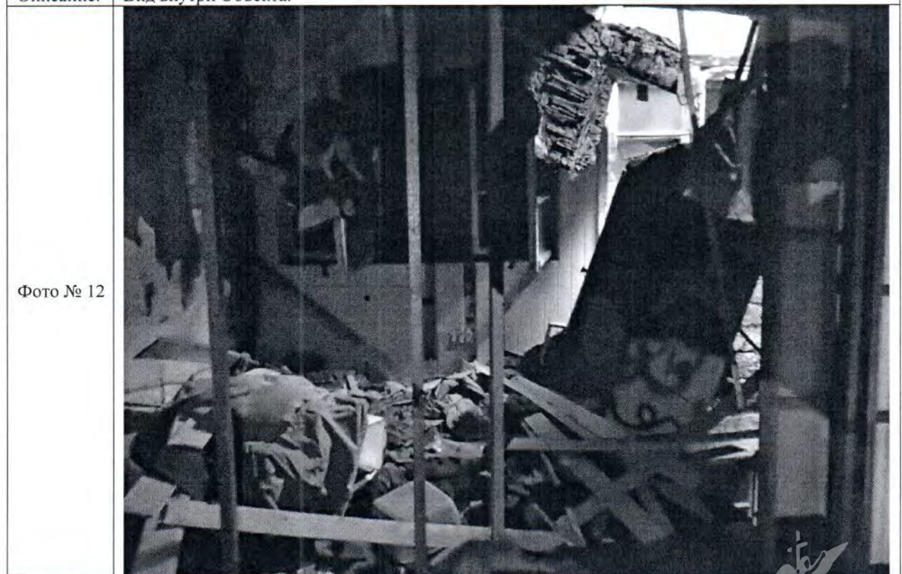
Описание: Вид внутри Объекта.
