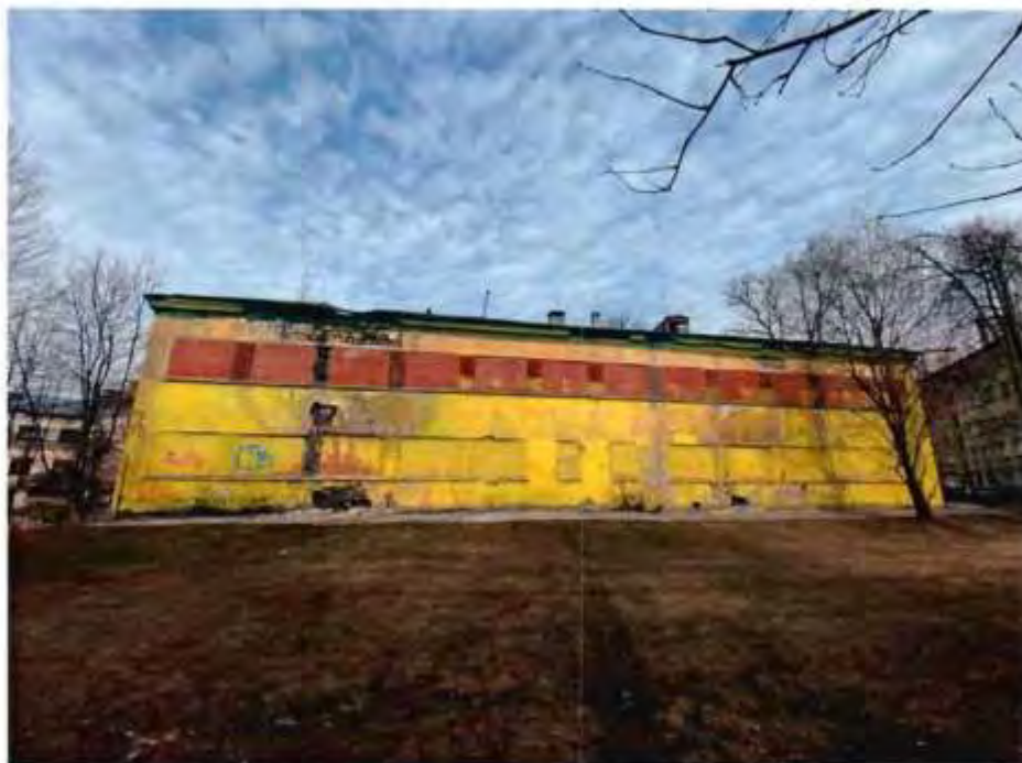
2. Южный фасад объекта культурного наследия.
