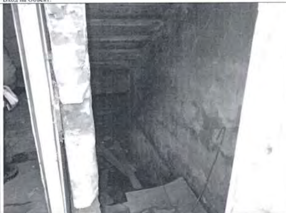
Описание: Вид внутри Объекта.
