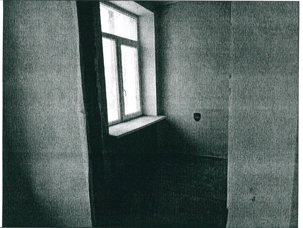
Описание: Вид внутри Объекта (ч.п. 13)
