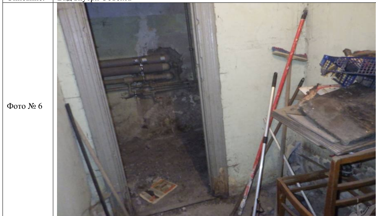
Описание: в ч.п. 24 Объекта демонтировано сантехническое оборудование (раковина)
