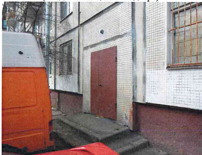
Фото №4 (вход в помещение с улицы)
