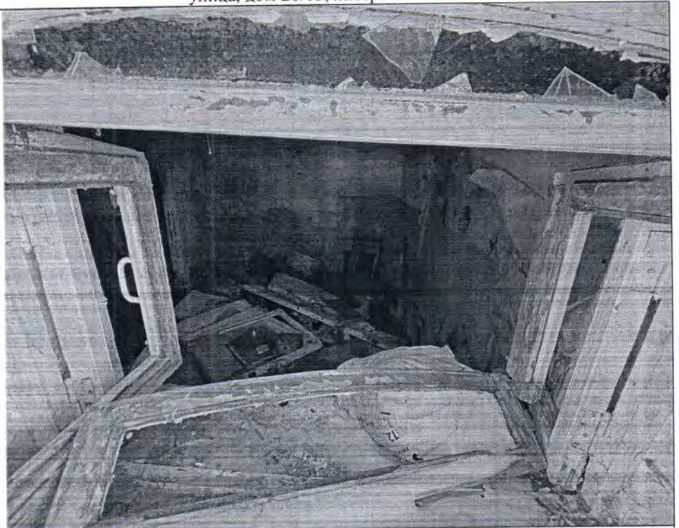
Описание: Вид на Объект
