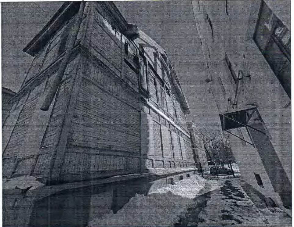
Описание: Вид на Объект
