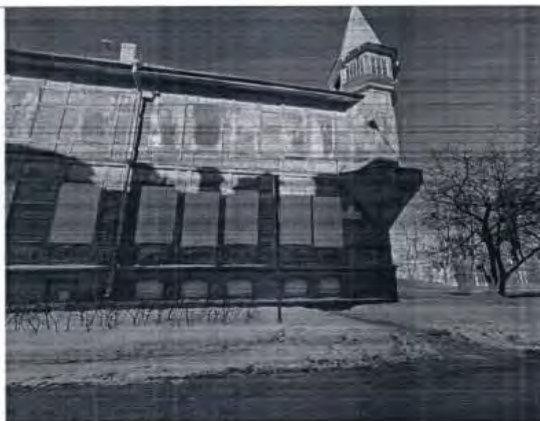
Описание: Вид на Объект
