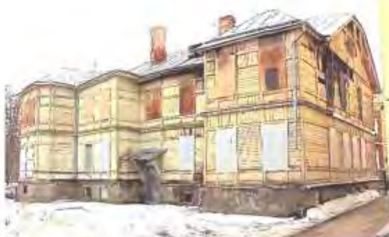
Фото 6. Вид на северный и западный фасады
