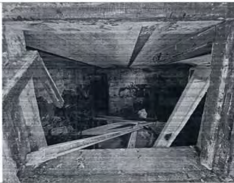
Описание: Вид на Объект
