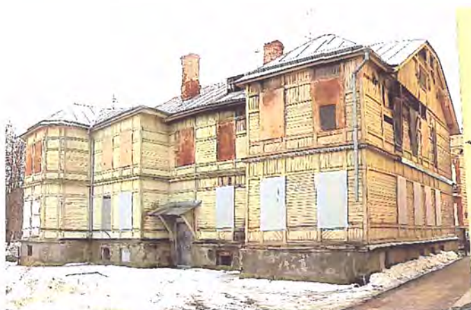
Фото 6. Вид на северный и западный фасады
