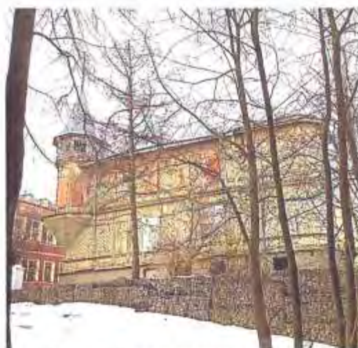
Фото 5. Вид на восточный фасад
