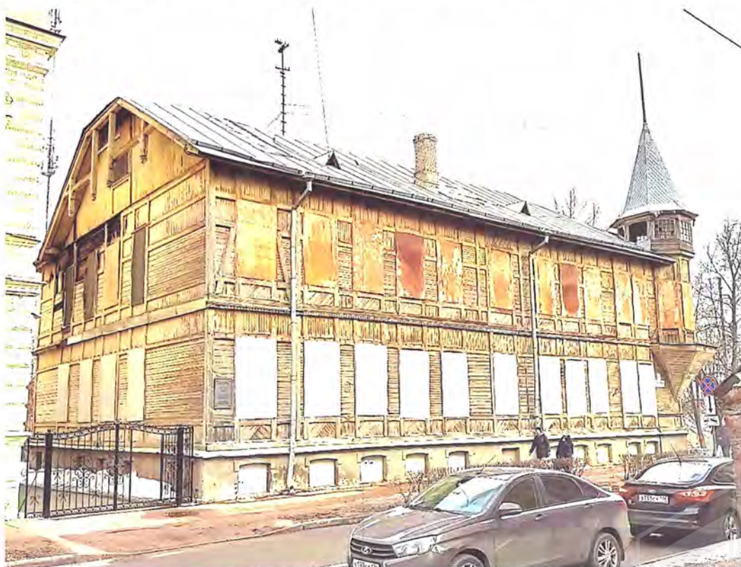
Фото 1. Вид на западный и южный фасады
