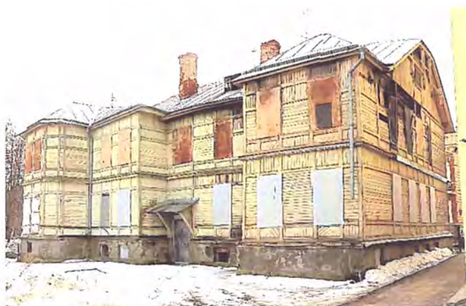
Фото 6. Вид на северный и западный фасады
