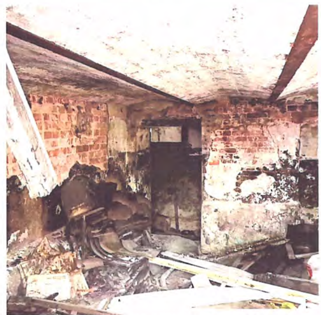
Фото 11. Вид на одно из подвальных помещений ч/з оконный проем
