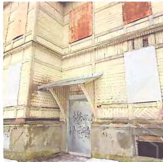
Фото 7. Вид на вход (северный фасад)
