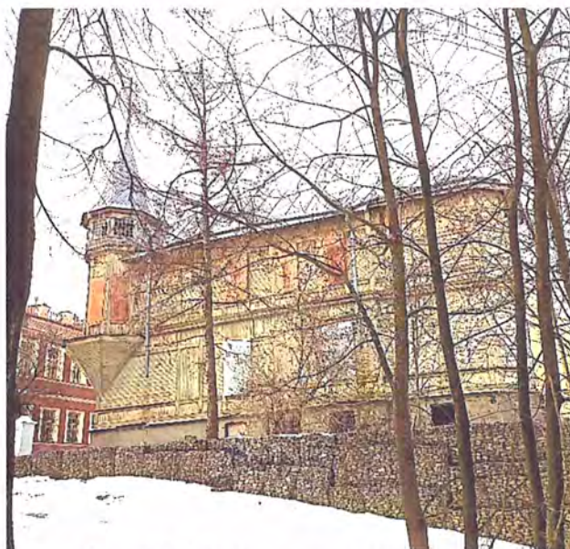
Фото 5. Вид на восточный фасад
