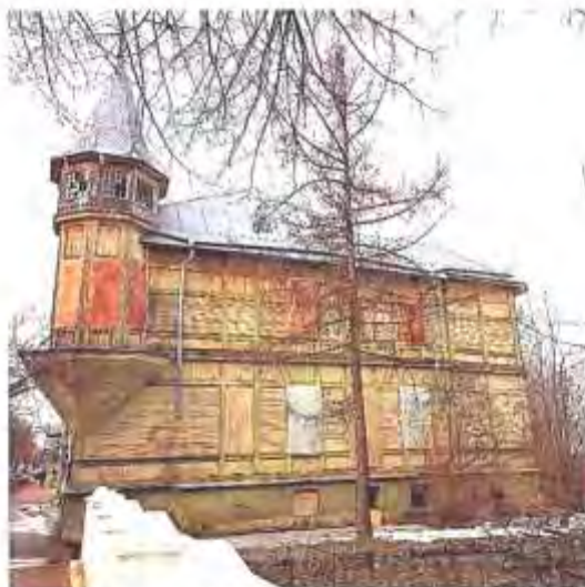
Фото 4. Вид на восточный фасад
