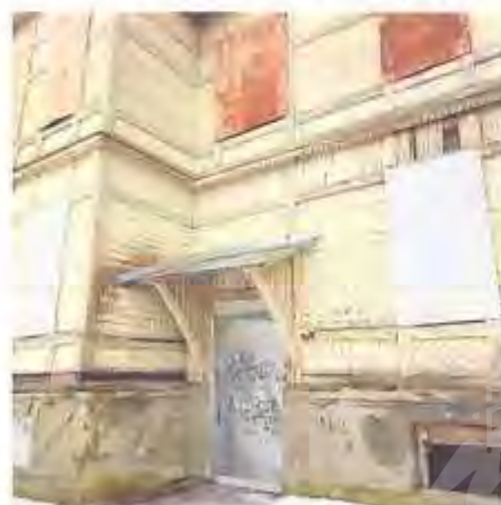
Фото 7. Вид на вход (северный фасад)
