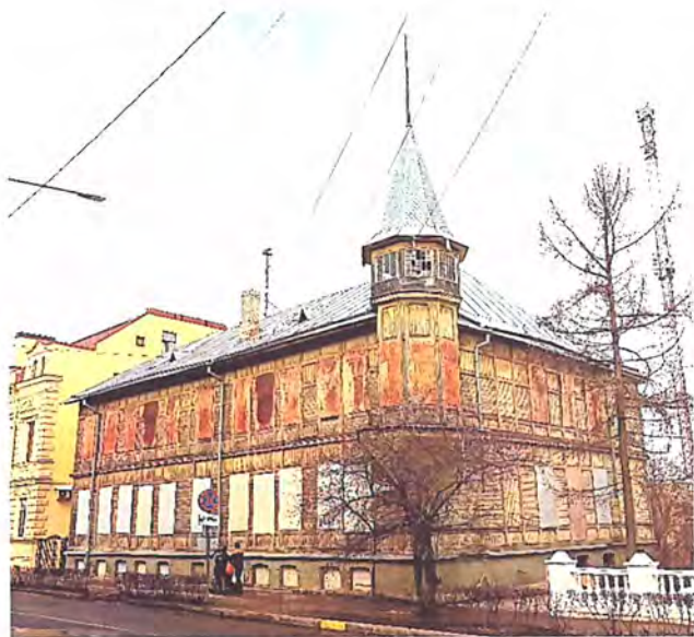
Фото 2. Вид на южный и восточный фасады
