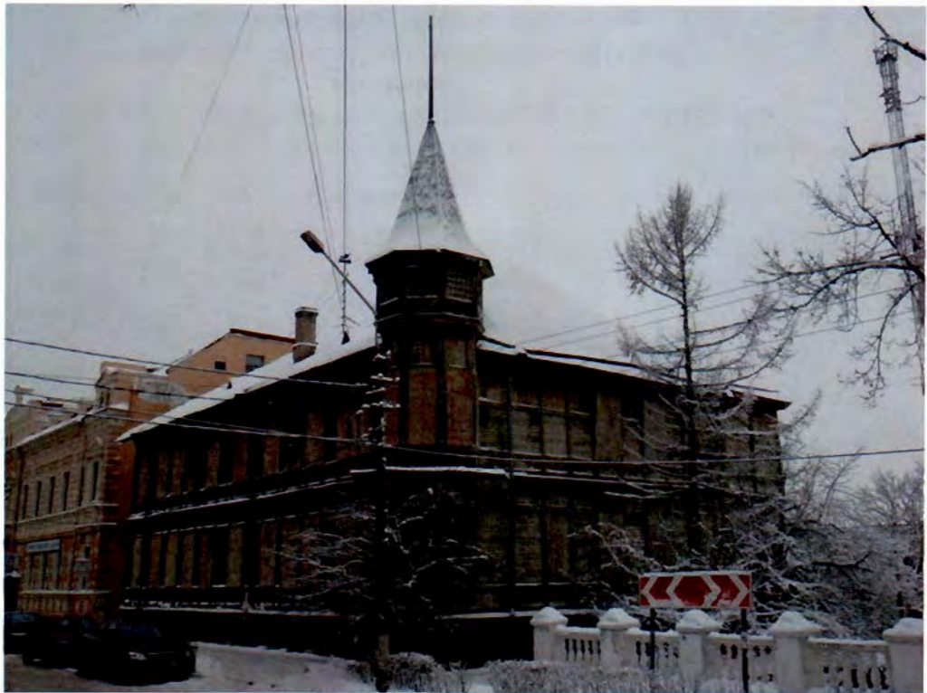
3. Юго-восточный угол здания
