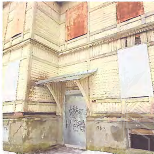
Фото 7. Вид на вход (северный фасад)
