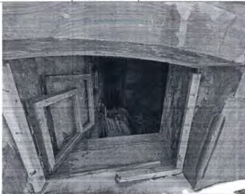
Описание: Вид на Объект
