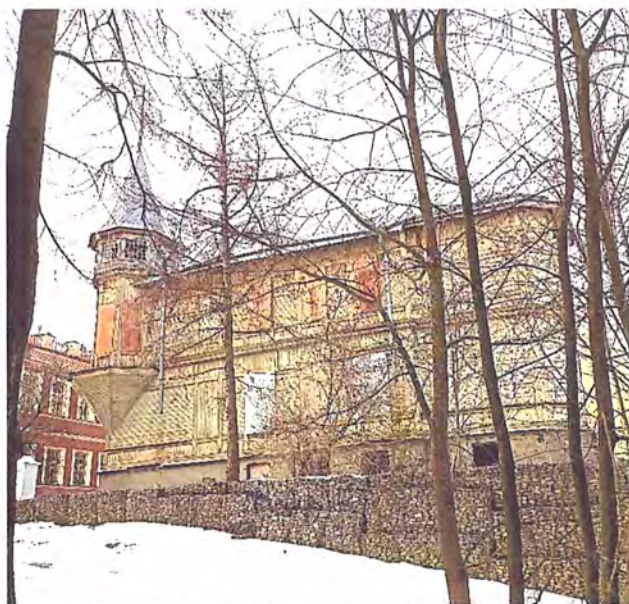
Фото 5. Вид на восточный фасад
