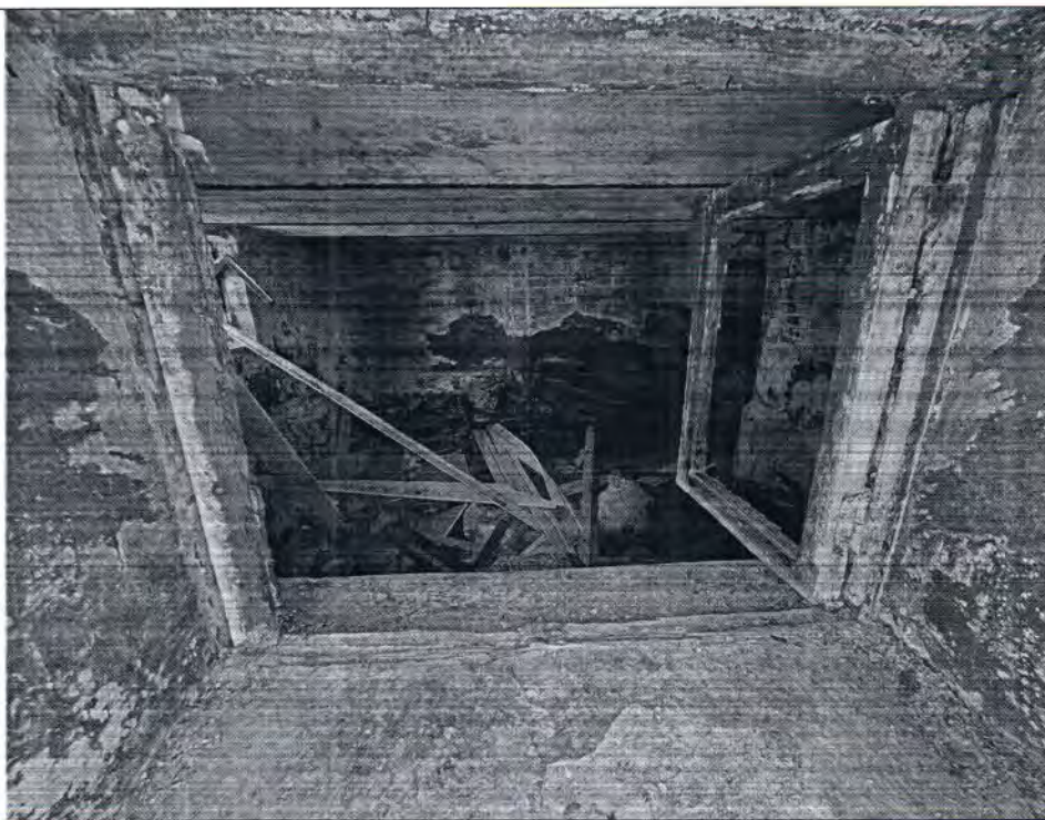
Описание: Вид на Объект
