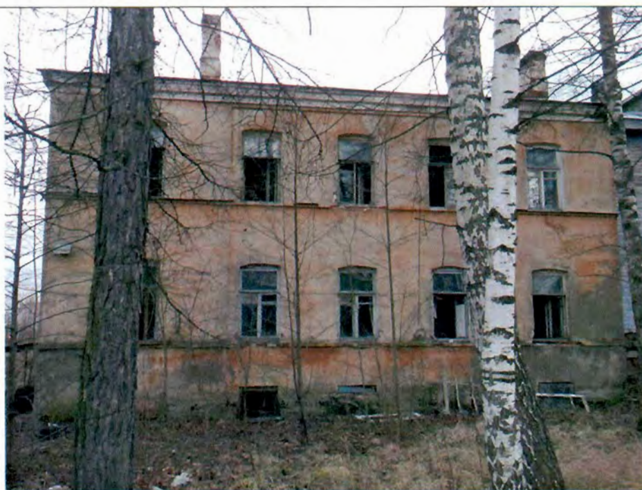
5. Северный флигель. Западный фасад.
