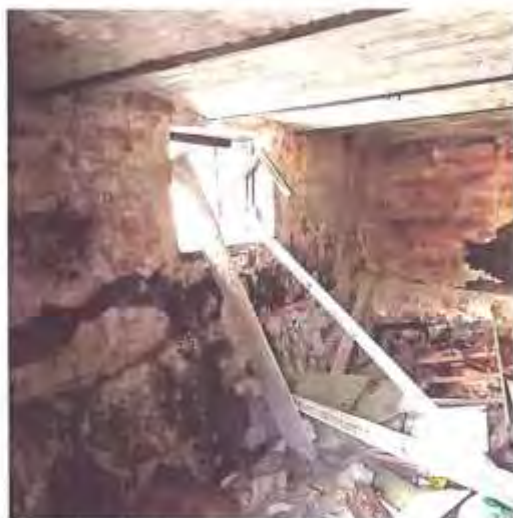
Фото 9. Вид на одно из подвальных помещений ч/з оконный проем
