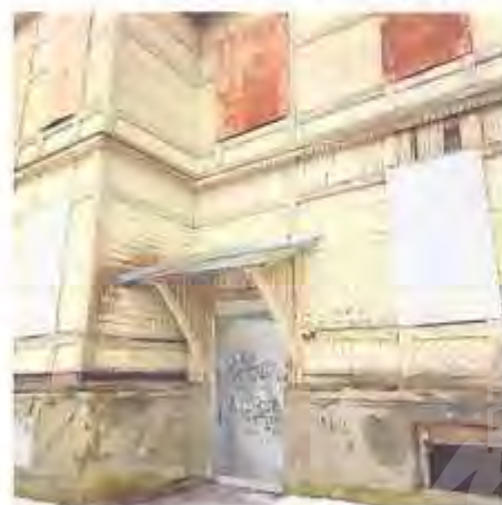
Фото 7. Вид на вход (северный фасад)
