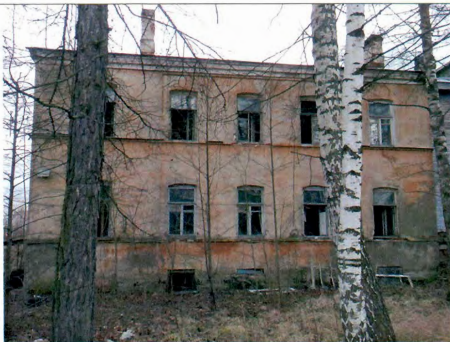
5. Северный флигель. Западный фасад.
