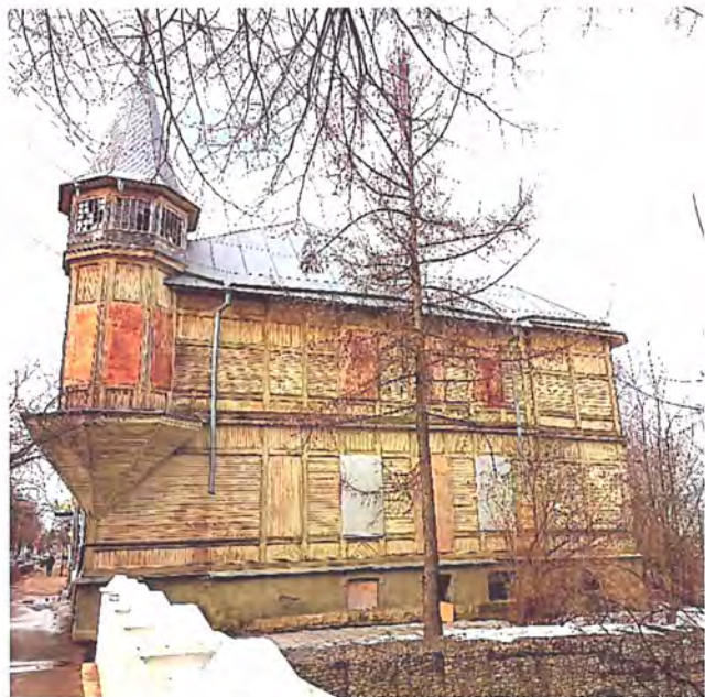
Фото 4. Вид на восточный фасад
