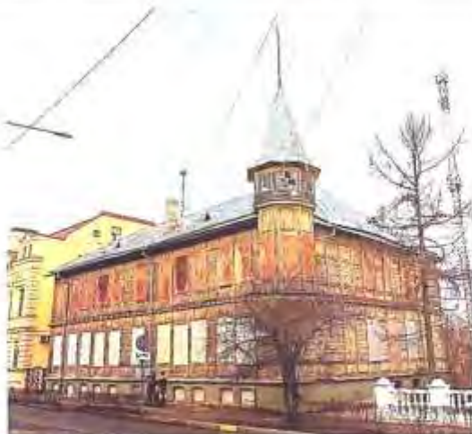
Фото 2. Вид на южный и восточный фасады
