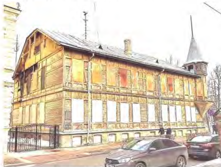
Фото 1. Вид на западный и южный фасады
