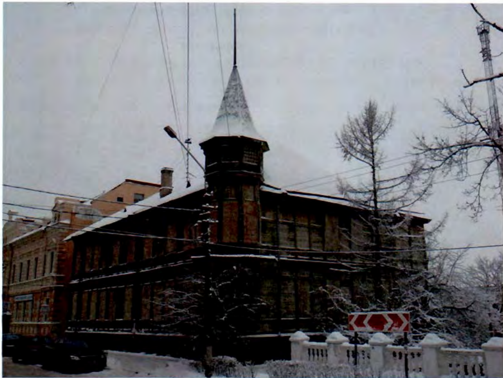
3. Юго-восточный угол здания
