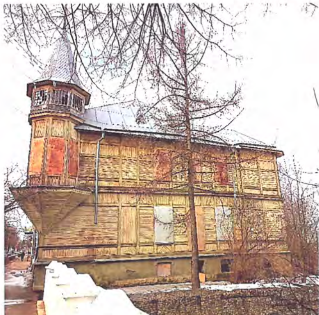
Фото 4. Вид на восточный фасад
