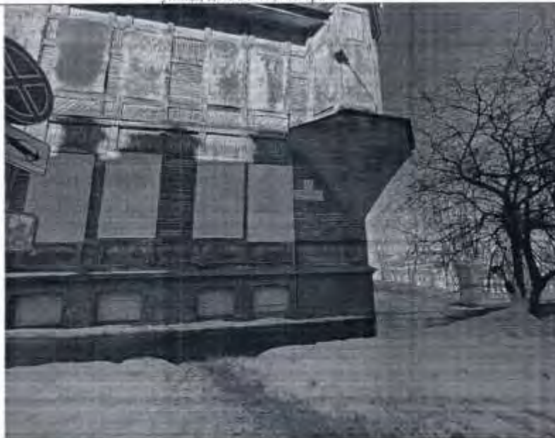
Описание: Вид на Объект
