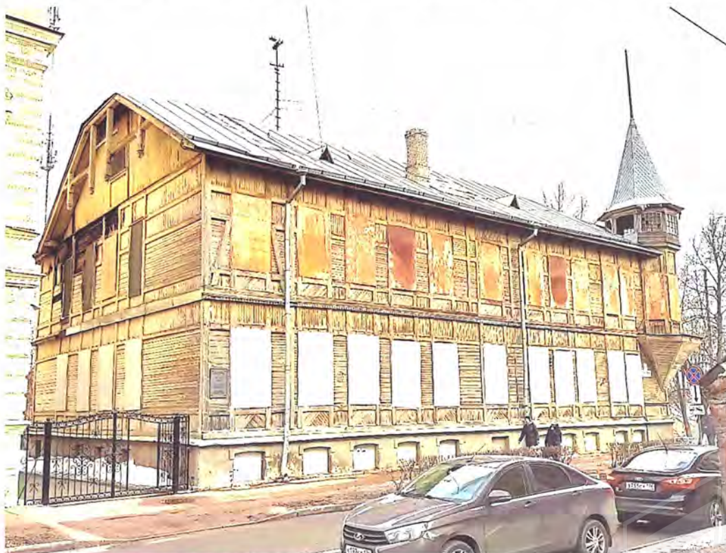
Фото 1. Вид на западный и южный фасады
