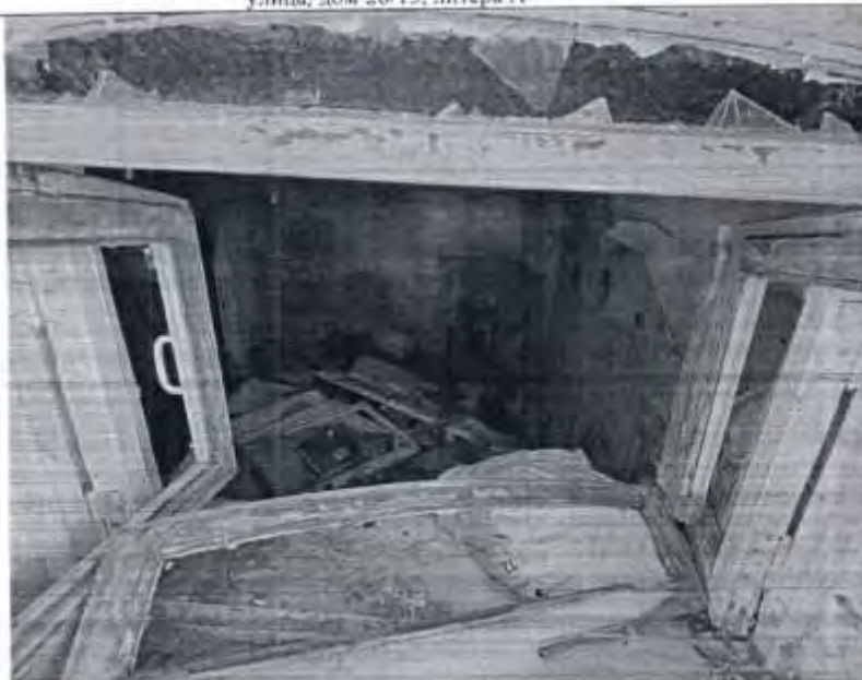
Описание: Вид на Объект
