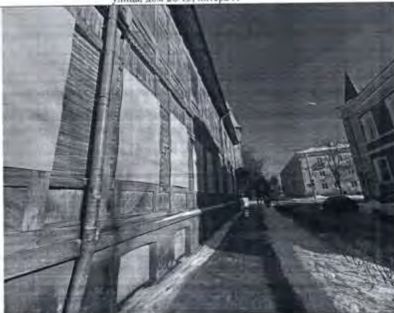
Описание: Вид на Объект
