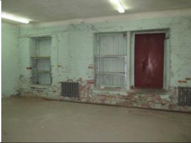
Фото № 13 – Внутреннее состояние помещения
