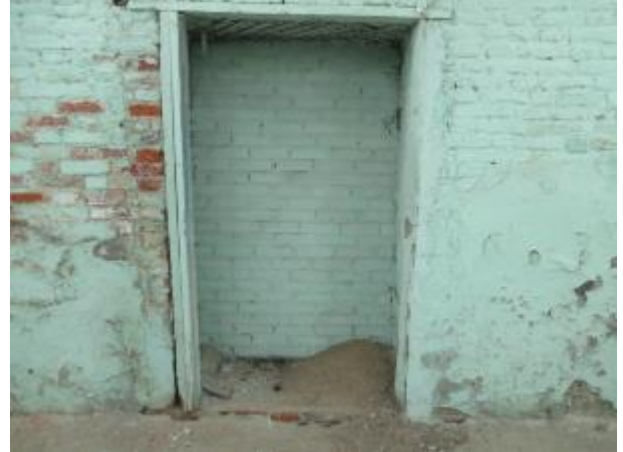
Фото № 16 – Внутреннее состояние помещения
