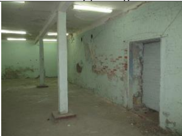
Фото № 11 – Вход в помещение со двора
