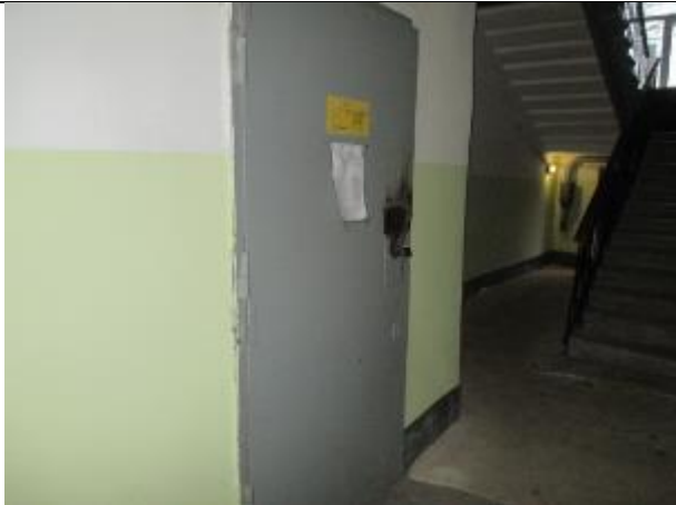
Фото № 7 – Вход в помещение с лестничной клетки
