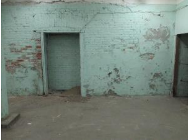
Фото № 15 – Внутреннее состояние помещения
