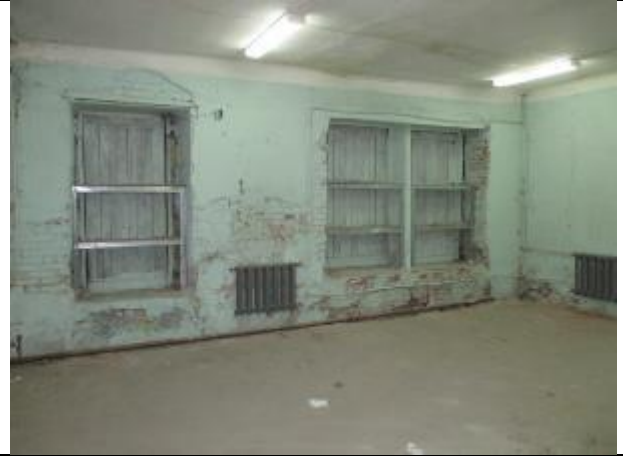
Фото № 14 – Внутреннее состояние помещения
