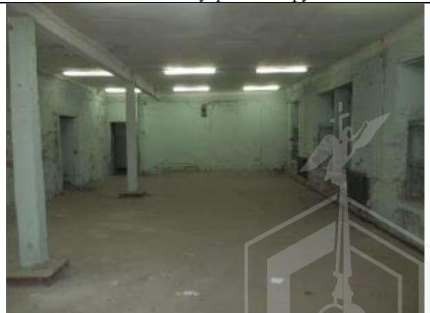
Фото № 12 – Внутреннее состояние помещения
