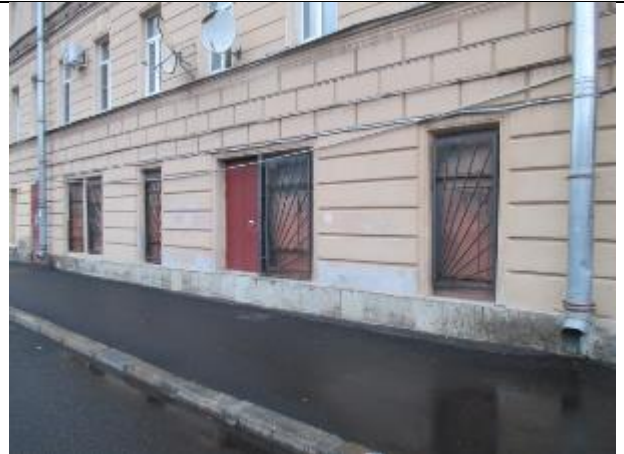
Фото № 8 – Оборудованный оконный проем, используемый как отдельный вход
