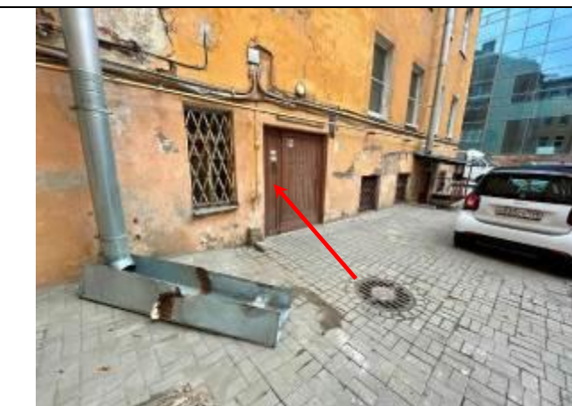
Фото 19. Входная и оконная группа Объекта оценки
