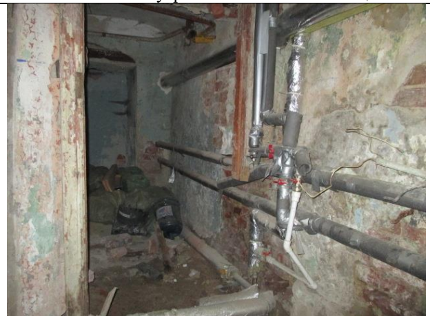
Фото № 18 – Внутреннее состояние помещения
