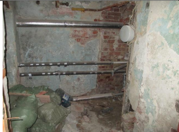
Фото № 9 – Внутреннее состояние помещения
