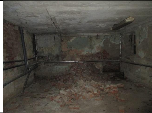
Фото № 15 – Внутреннее состояние помещения
