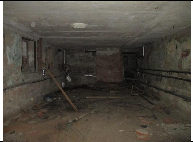
Фото № 16 – Внутреннее состояние помещения
