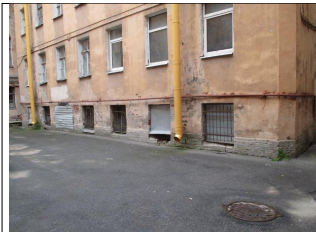
Фото № 7 – Расположение окон помещения
