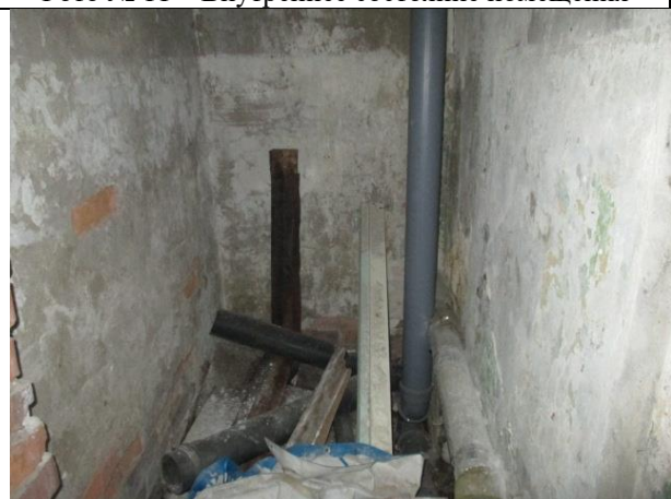
Фото № 13 – Внутреннее состояние помещения
