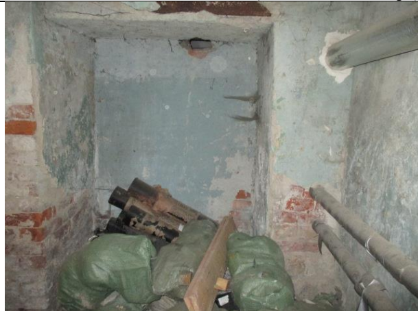
Фото № 10 – Внутреннее состояние помещения
