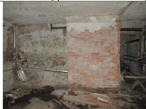
Фото № 17 – Внутреннее состояние помещения
