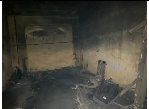
Фото № 14 - Внутреннее состояние здания
