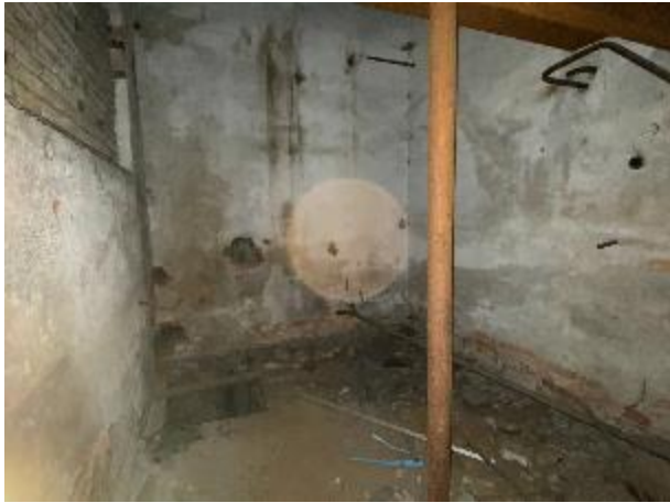
Фото № 11 - Внутреннее состояние здания
