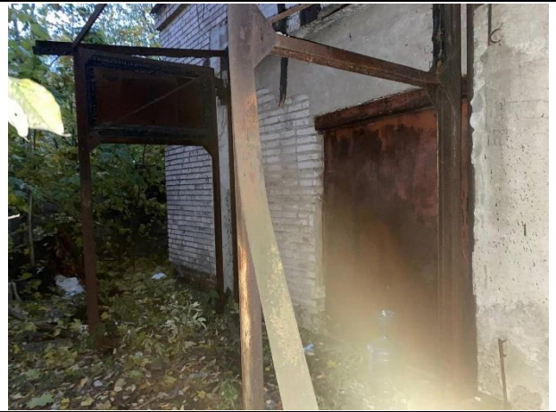
Фото № 10 – Вход в здание
