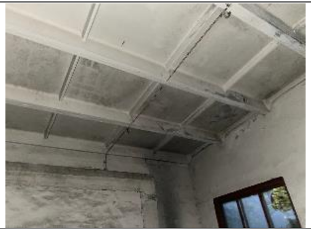
Фото № 18 - Внутреннее состояние здания
