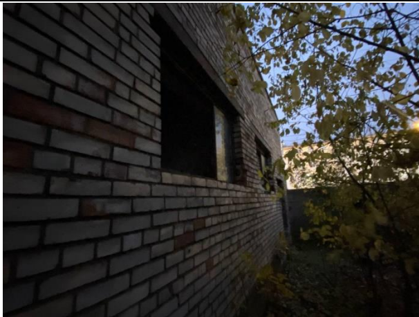
Фото № 5 - Внешний вид здания
