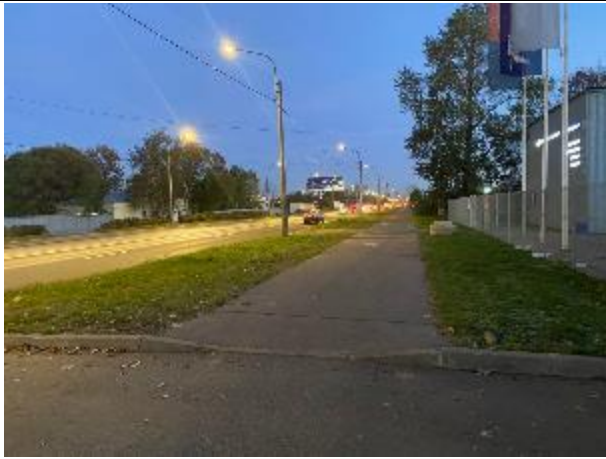
Фото № 1 - Подъездные пути и окружение объекта
