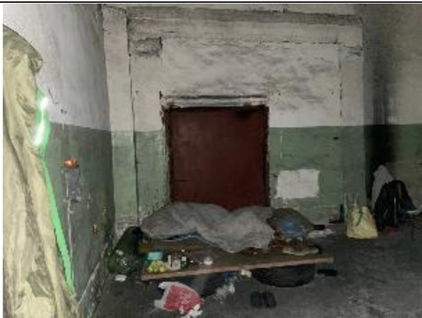
Фото № 13 - Внутреннее состояние здания
