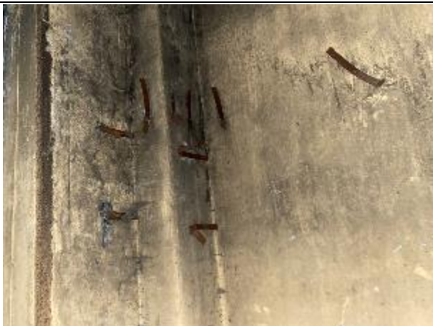
Фото № 15 - Внутреннее состояние здания
