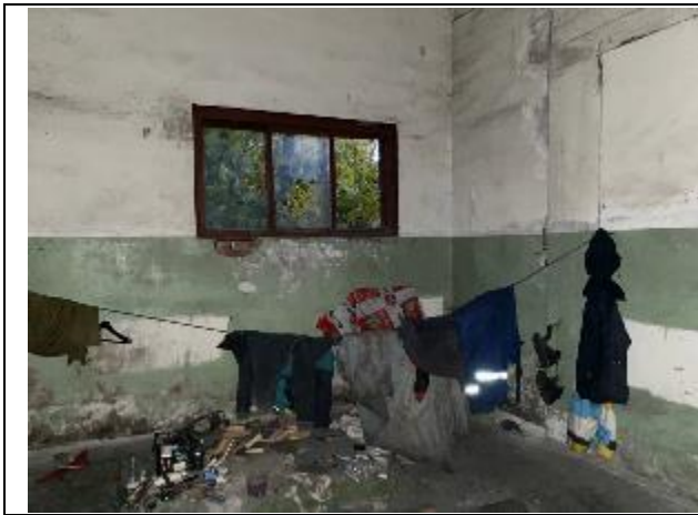
Фото № 17 - Внутреннее состояние здания
