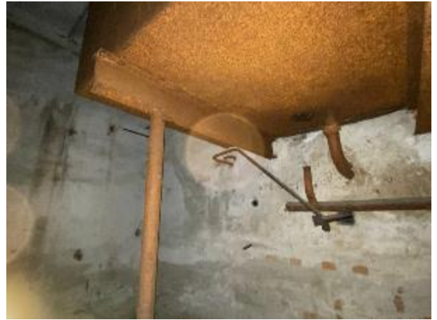
Фото № 12 - Внутреннее состояние здания
