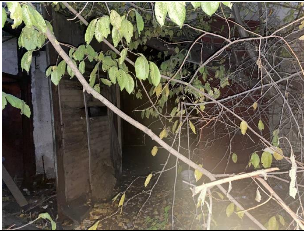
Фото № 9 – Вход в здание
