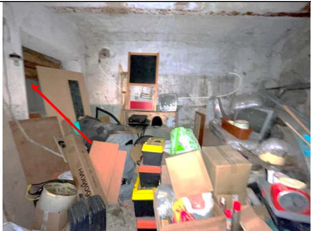
Фото 16. Типичное состояние Объекта оценки, оконная группа Объекта оценки
