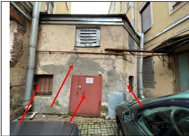
Фото 13. Вид здания расположения Объекта оценки, входная группа Объекта оценки, оконная группа Объекта оценки
