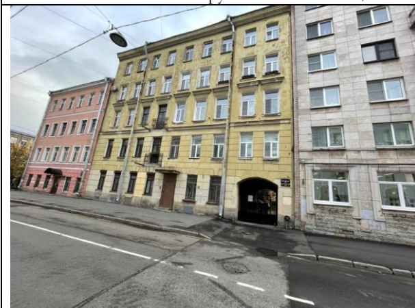
Фото 13. Вид здания расположения Объекта оценки (Дептарная улица), проход через арку к Объекту оценки
