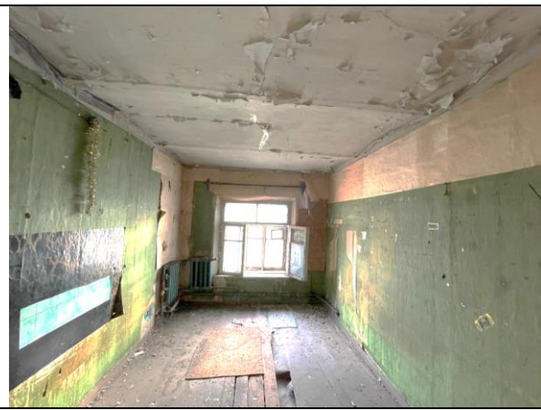
Фото 25. Типичное состояние Объекта оценки
