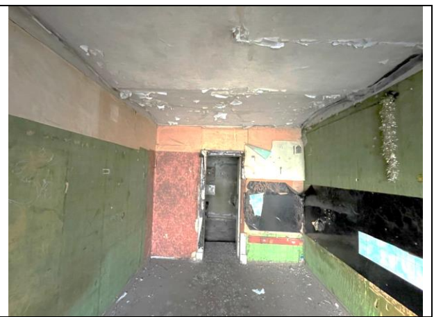
Фото 26. Типичное состояние Объекта оценки
