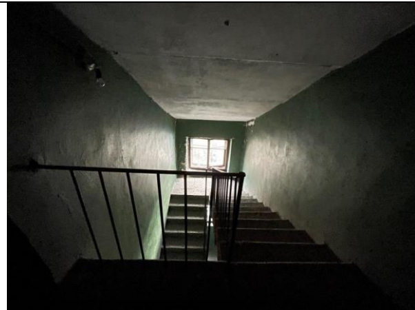
Фото 19. Лестница Объекта оценки
