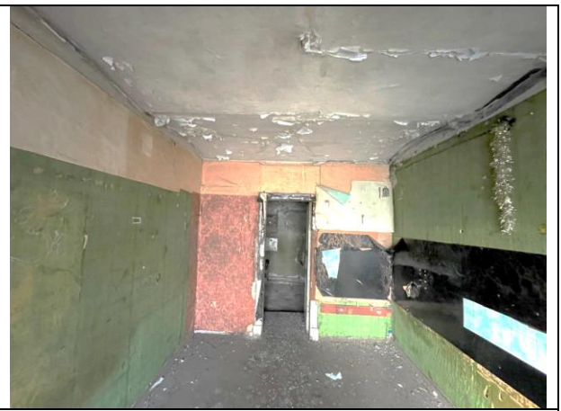
Фото 26. Типичное состояние Объекта оценки
