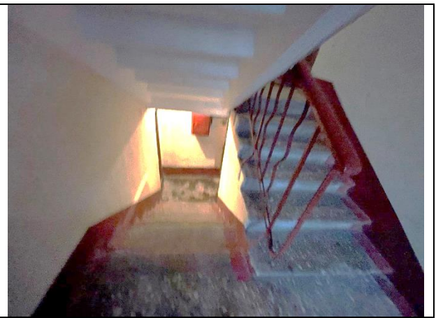
Фото 20. Лестничный проём Объекта оценки
