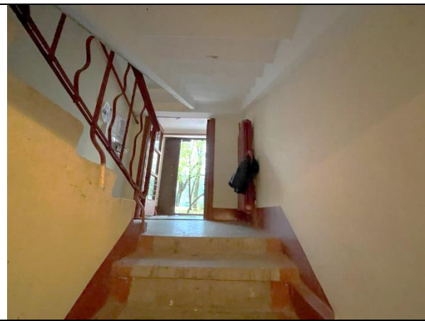
Фото 19. Лестничный проём Объекта оценки
