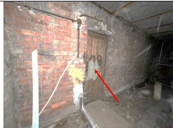
Фото 26. Проход в помещение
