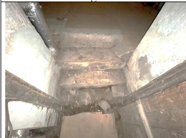
Фото 27. Проход в помещение
