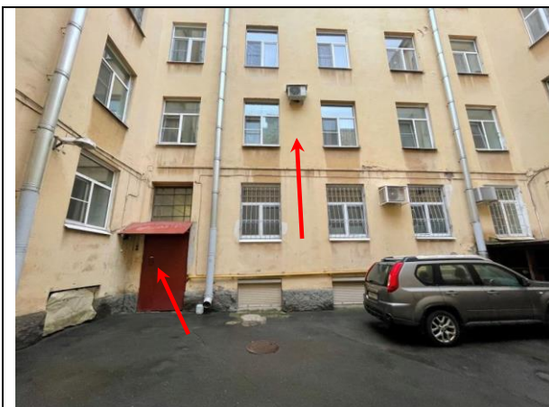
Фото 15. Вид здания расположения Объекта оценки, входная группа Объекта оценки (общий вход)
