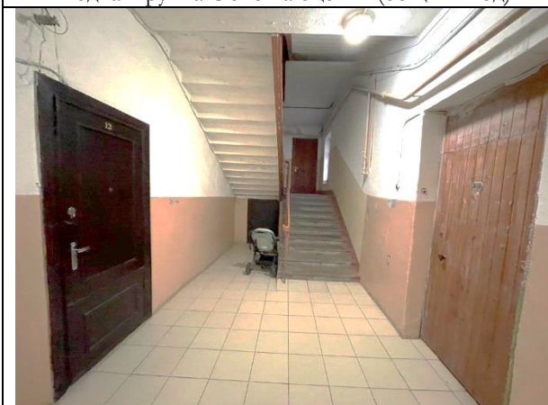
Фото 17. Лестничная клетка Объекта оценки
