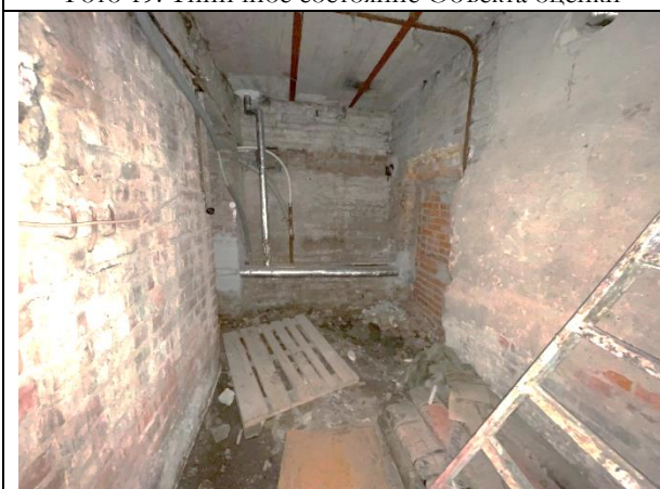
Фото 21. Типичное состояние Объекта оценки
