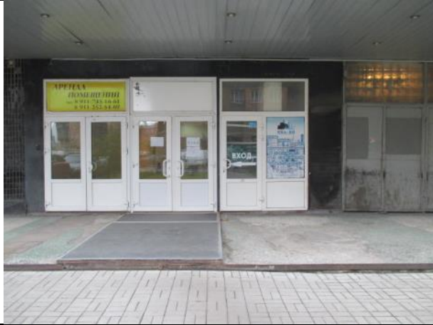
Фото № 7 – Общий вход с улицы
