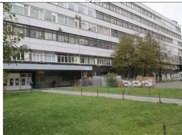
Фото № 4 – Ближайшее окружение и подъездные пути
