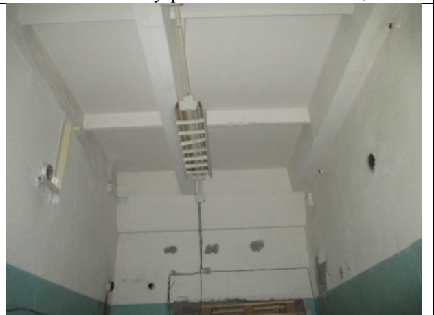
Фото № 20 – Внутреннее состояние помещения
