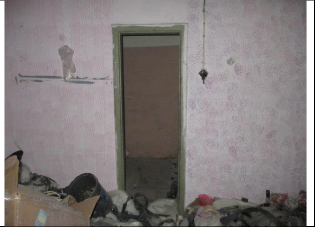
Фото № 16 – Внутреннее состояние помещения
