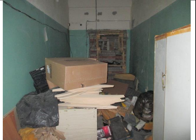
Фото № 18 – Внутреннее состояние помещения
