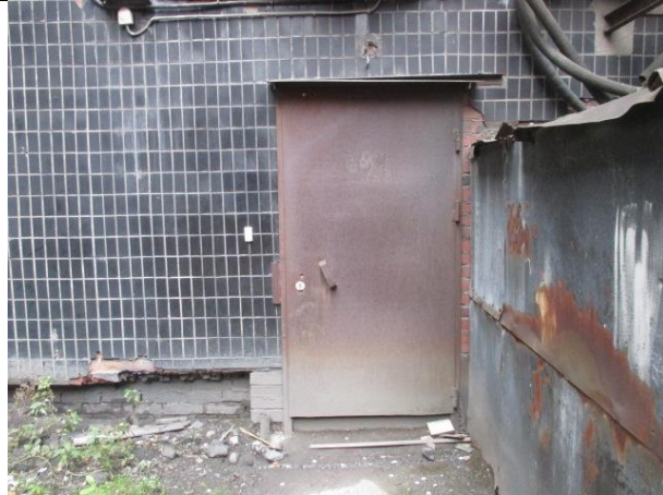
Фото № 9 – Общий вход со двора
