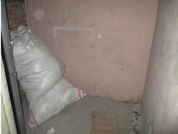
Фото № 17 – Внутреннее состояние помещения
