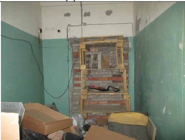
Фото № 19 – Внутреннее состояние помещения
