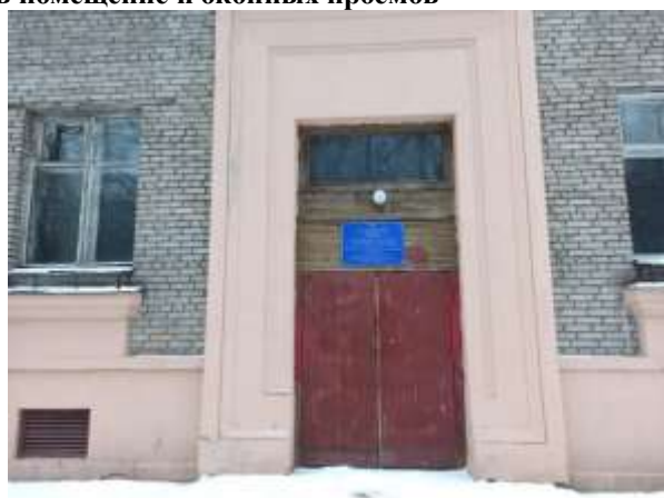
Фото 4. Общий вход 2 со двора (закрыт)
