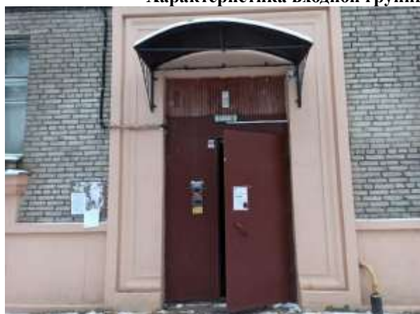
Фото 3. Общий вход 1 со двора
