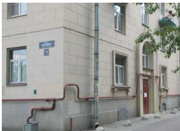
Фото 3. 1 общий вход с торца здания
