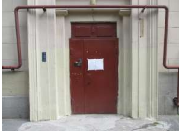
Фото 4. 1 общий вход с торца здания
