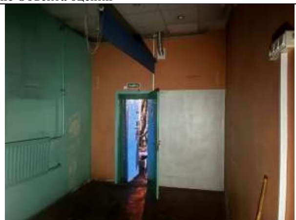
Фото 7. Внутреннее состояние Объекта оценки
