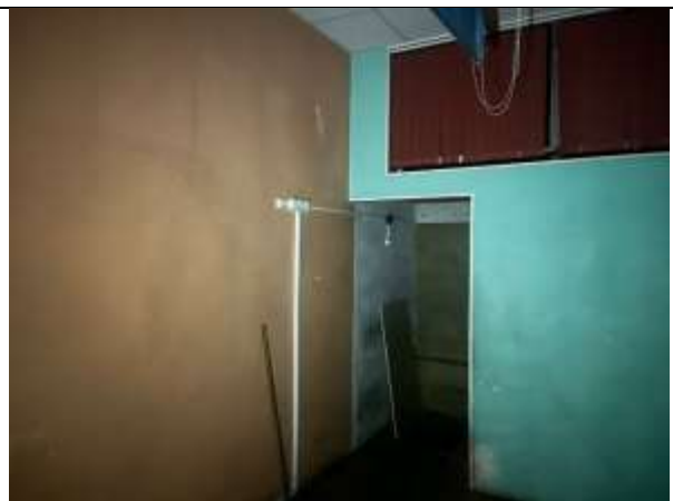
Фото 9. Внутреннее состояние Объекта оценки
