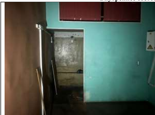
Фото 6. Внутреннее состояние Объекта оценки
