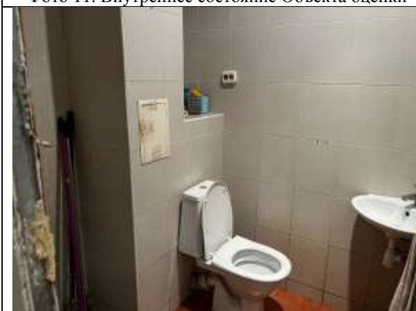
Фото 13. Внутреннее состояние Объекта оценки
