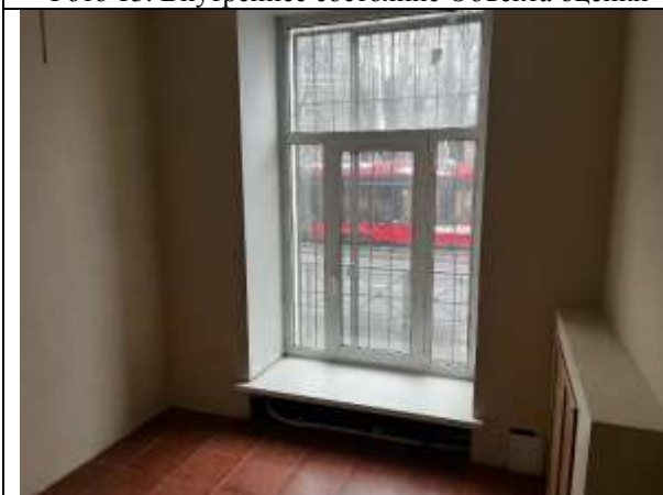
Фото 15. Внутреннее состояние Объекта оценки
