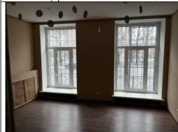
Фото 11. Внутреннее состояние Объекта оценки
