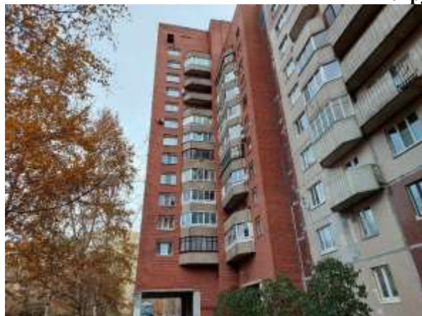
Фото 1. Вид здания, в котором расположен Объект оценки
